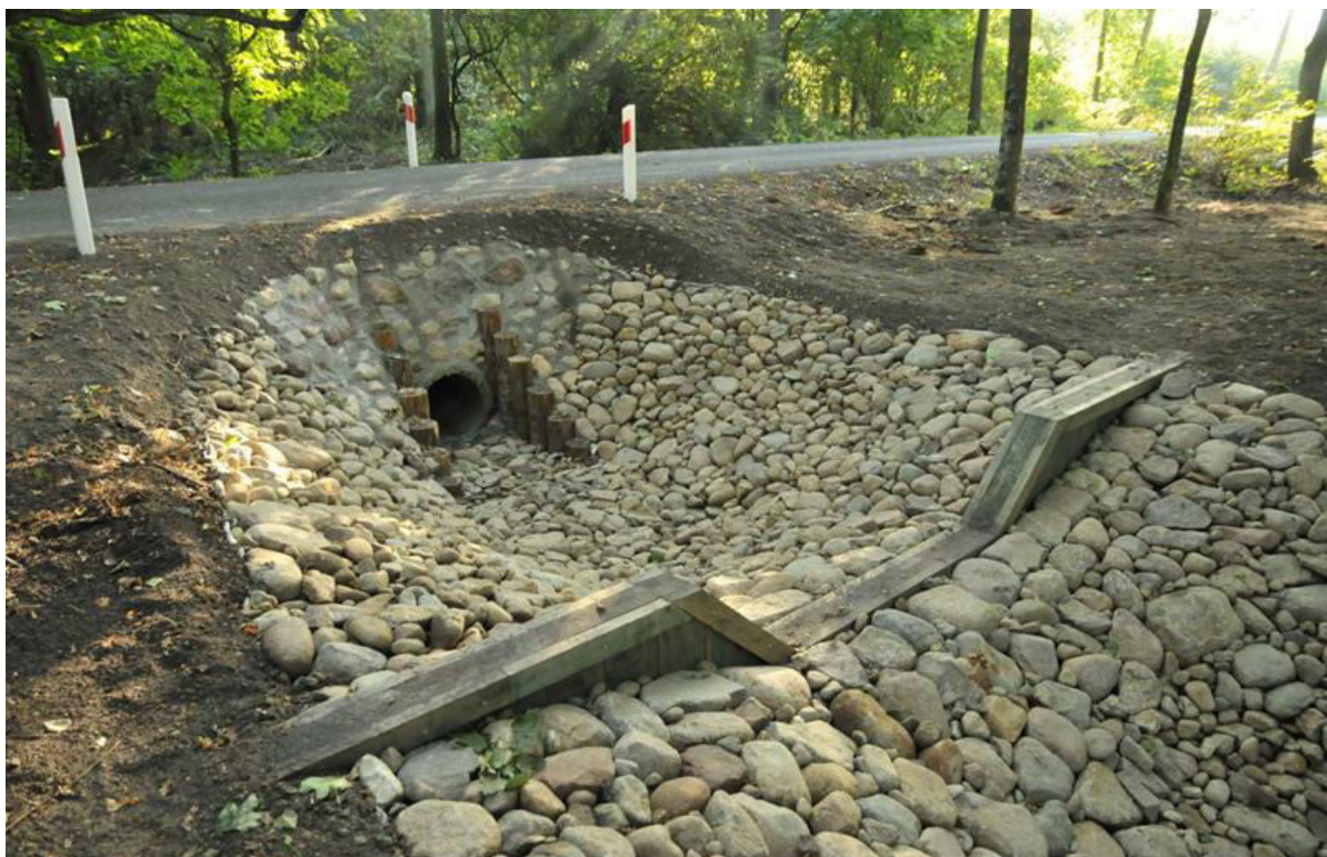
Fotografia 30. Obiekt tzw. małej retencji na terenie leśnictwa Młyny po wybudowaniu (2019 r.), autor: Paweł Kaczorowski
