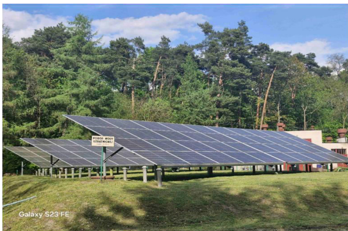
Fotografia 40. Panele fotowoltaiczne zasilające biurowiec, autor: Wojciech Wojtasiński
