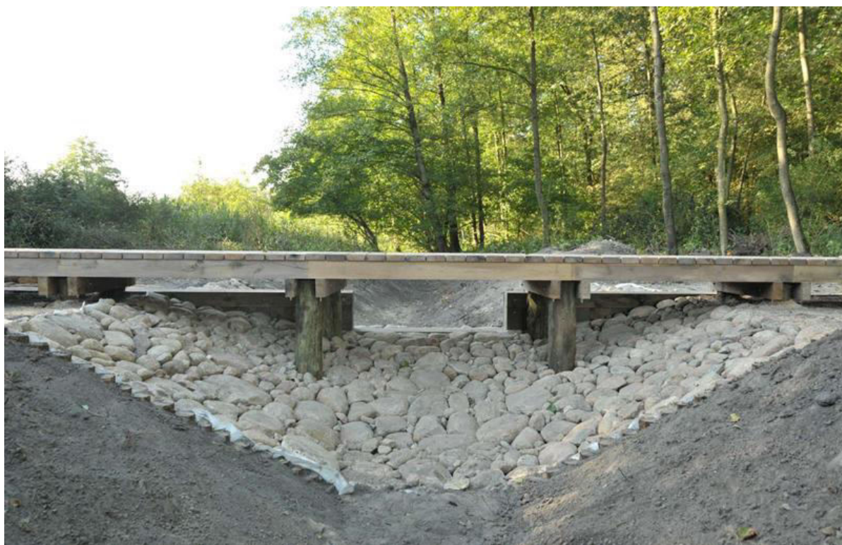
Fotografia 31. Obiekt tzw. małej retencji na terenie leśnictwa Młyny po wybudowaniu (2019 r.), autor: Paweł Kaczorowski
