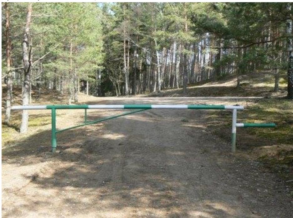
Ryc. 1 Przykład konstrukcji szlabanu
