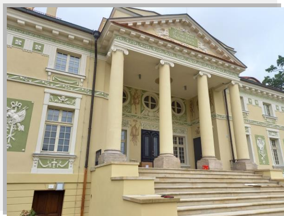
Fot. 1. Rozbudowa i modernizacja kompleksu pałacowego w Lewkowie
