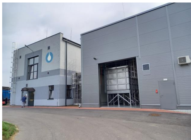
Fot. 4. Budowa hali z instalacją suszenia osadów ściekowych na terenie oczyszczalni ścieków w miejscowości Rąbczyn
