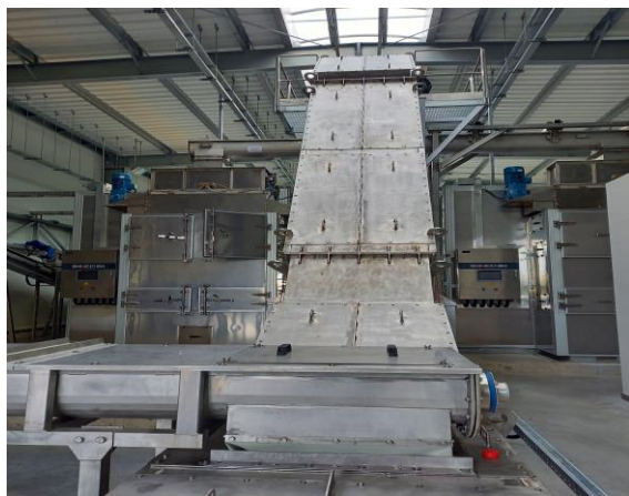
Fot. 3. Budowa hali z instalacją suszenia osadów ściekowych na terenie oczyszczalni ścieków w miejscowości Rąbczyn
