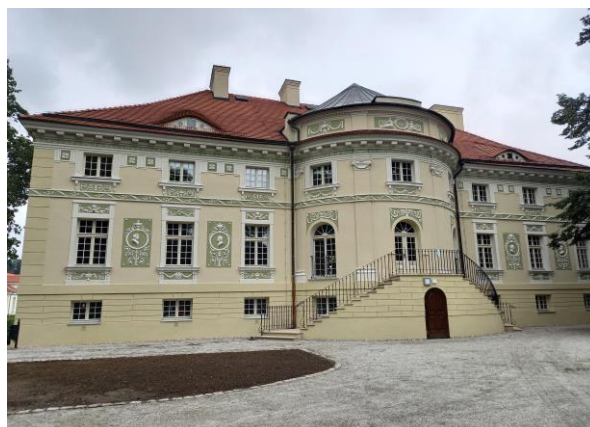
Fot. 2. Rozbudowa i modernizacja kompleksu pałacowego w Lewkowie
