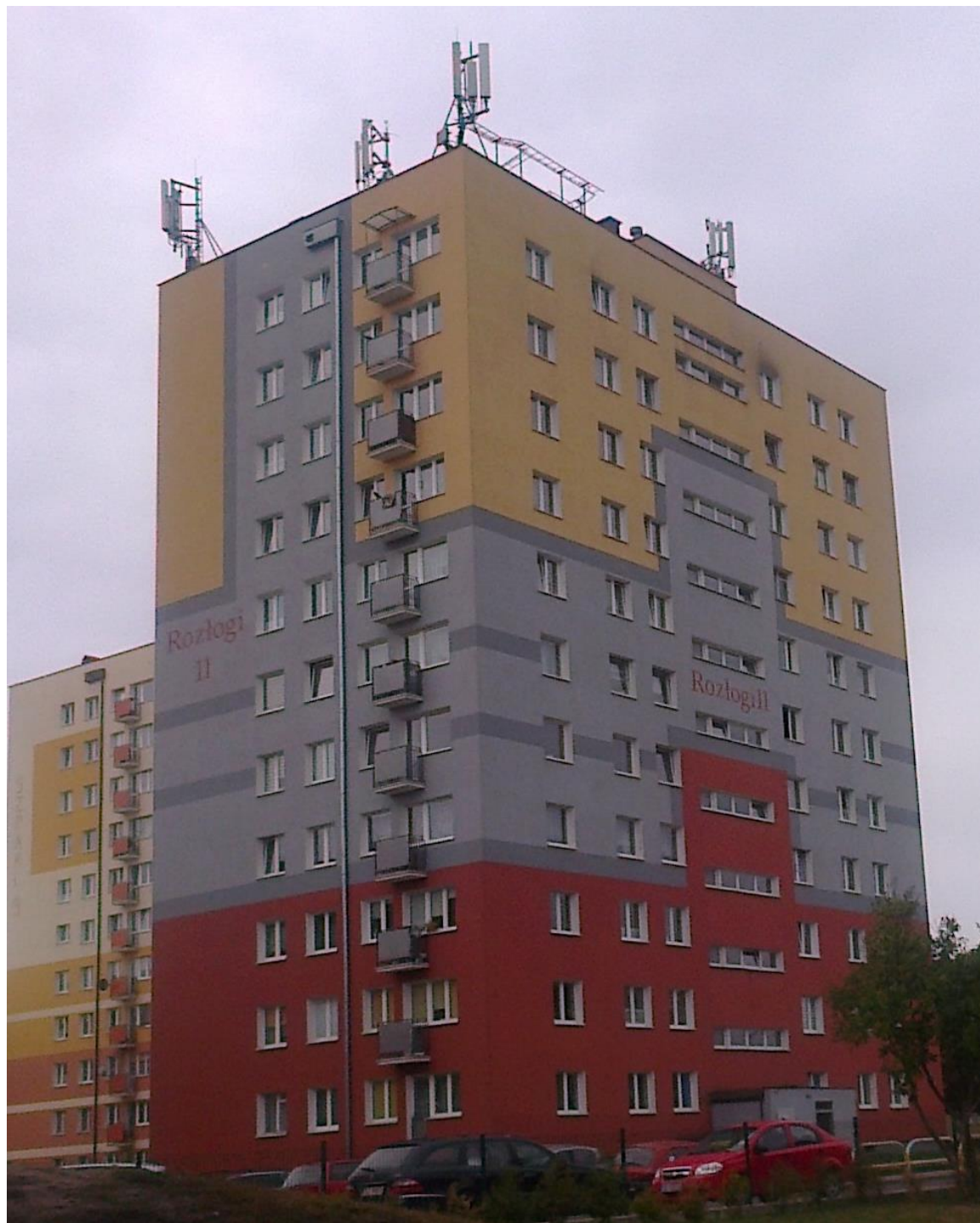
Fot. 1: Widok anten stacji bazowych ID: GDA0028D oraz ID 40103N!, zlokalizowanych przy ul. Rozłogi 11 w Gdańsku
