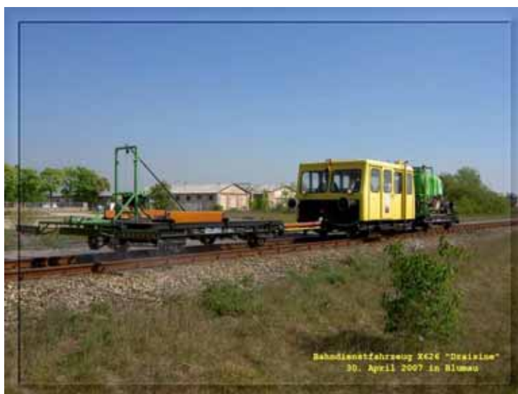
Fot. 33 Zbiorniki ze środkami chemicznymi zamontowane na platformie kolejowej Źródło: http://www.bahnbilder.de/name/einzelbild/number/101131/kategorie/oesterreich~bahndienstfahrzeuge~x626.html
