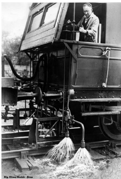
Fot. 14 Pociąg specjalny do chemicznego odchwasczania torów, zdjęcie z września 1949 roku źródło http://www.drehscheibe-foren.de/foren/read.php?17,3865936,3865936
