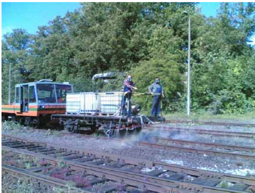
Fot. 24 Zbiorniki ze środkami chemicznymi zamontowane na platformie kolejowej źródło: http://profeo.pl/group/topic/29614/.1
