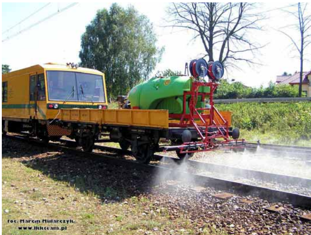
Fot. 3 Opryskiwacz kolejowy zamontowany na wózku motorowym MS29 z platformą PWM10 na stacji Motycz Źródło: http://www.lkkteam.pl/galeria2/displayimage.php?album=21&pos=2
