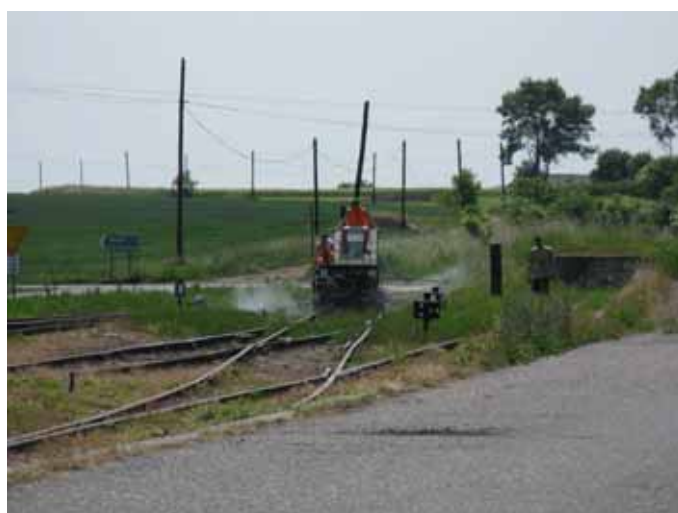
Fot. 27 Zbiorniki ze środkami chemicznymi zamontowane na drezynie Źródło: http://kolejpodludecka.pl/portal-galeria-zdjecie-387.html
