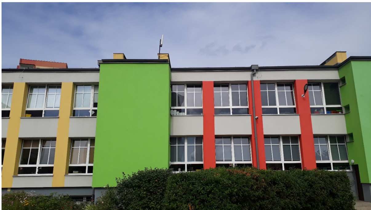
Rys. 2 Miejsce montażu SMS PEM – Publiczne Przedszkole nr 4 w Pile – widok z poziomu gruntu
