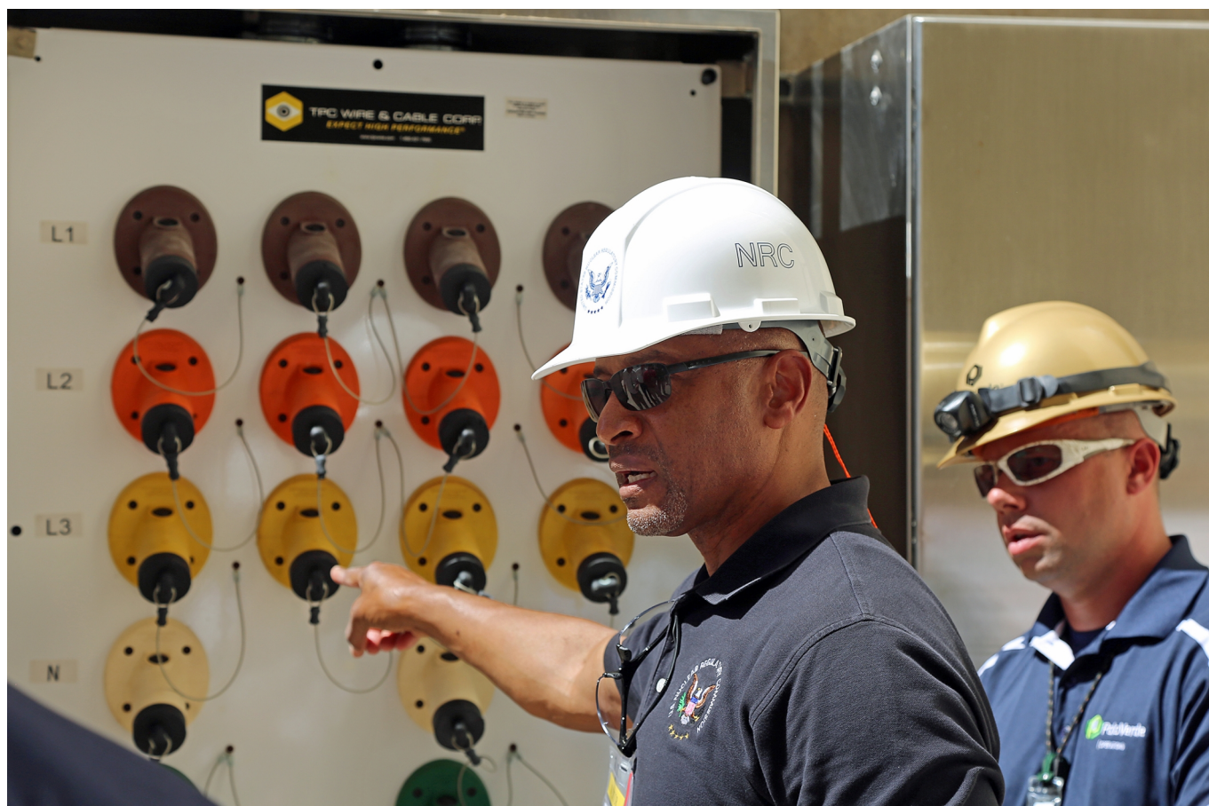
Fot. 8. Inspektorzy NRC w Elektrowni Jądrowej Palo Verde w pobliżu Tonopah w Arizonie przy przyłączach elektrycznych umożliwiających podłączenie przewoźnych agregatów prądotwórczych należących do wyposażenia awaryjnego FLEX (fot. U.S. NRC).
