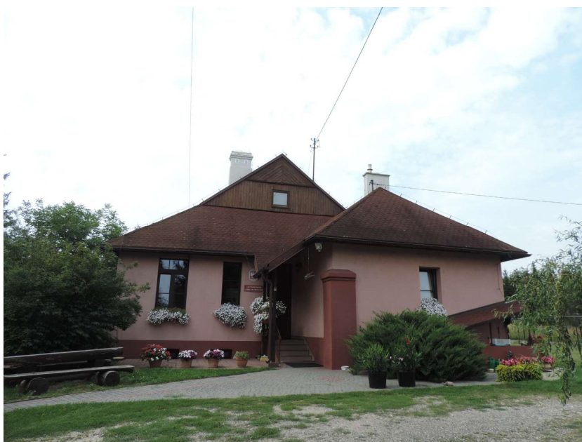
Foto Nr 2. – Elewacja boczna budynku mieszkalnego leśniczówki Brzustów
