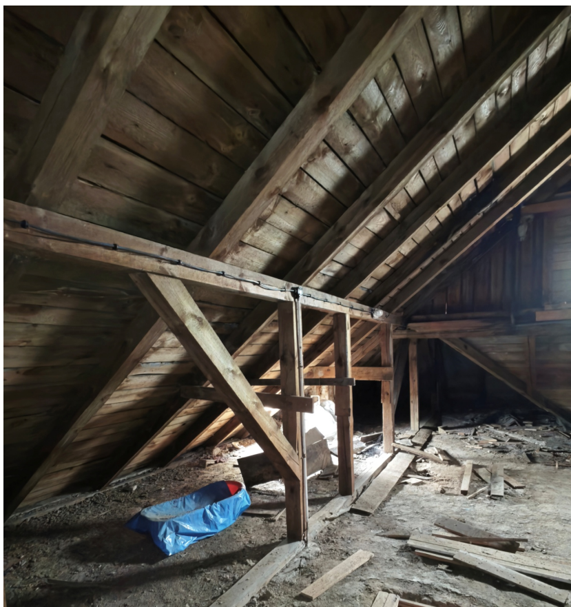
Foto Nr 12. – Obecny stan wieżby dachowej
