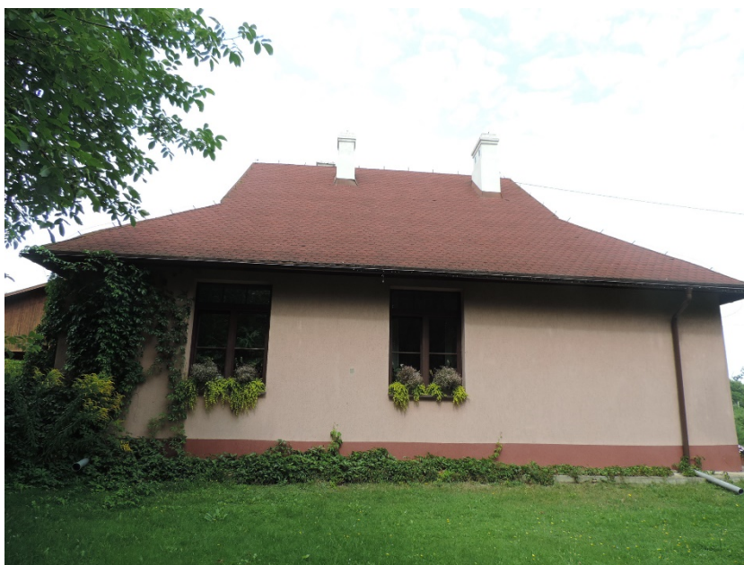
Foto Nr 1. – Elewacja frontowa budynku mieszkalnego leśniczówki Brzustów
