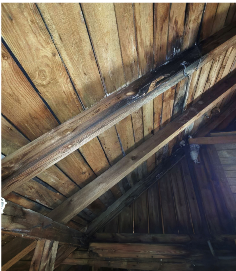
Foto Nr 13. - Miejsce kotwienia liny naciągu oraz sztycy Nr 1
