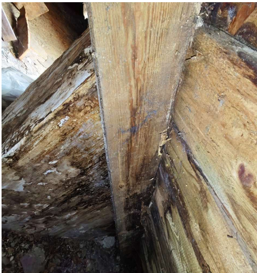
Foto Nr 11. – Krokiew przy kominie Nr 4
