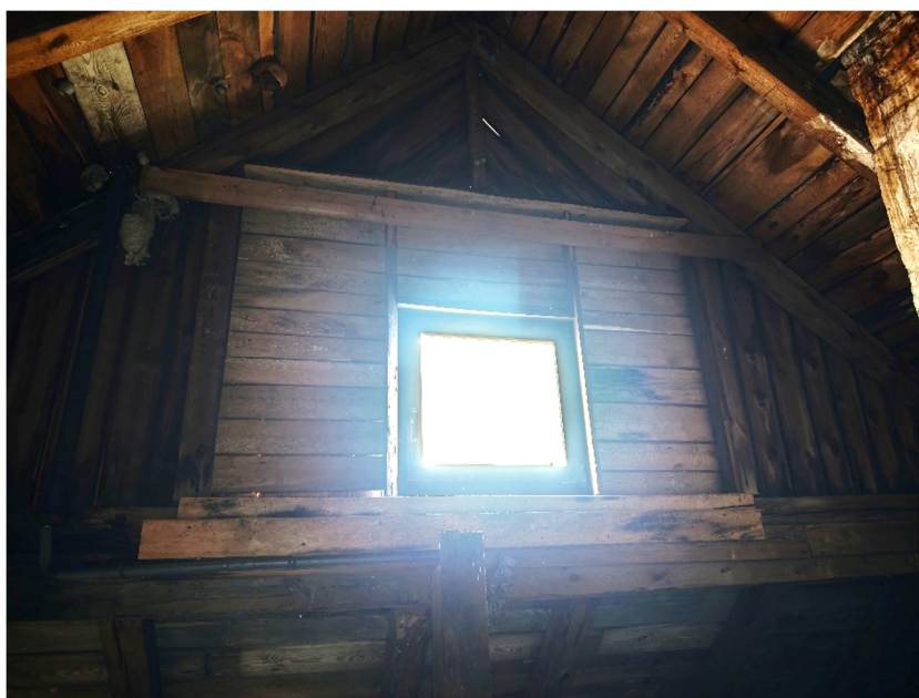
Foto Nr 14. – Ściana szczytowa Nr 1 od strony poddasza nieużytkowego
