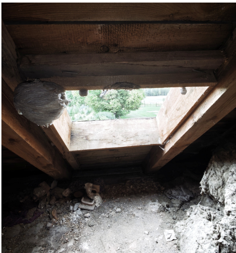
Foto Nr 15. - Istn. drewniany wyłaz dachowy
