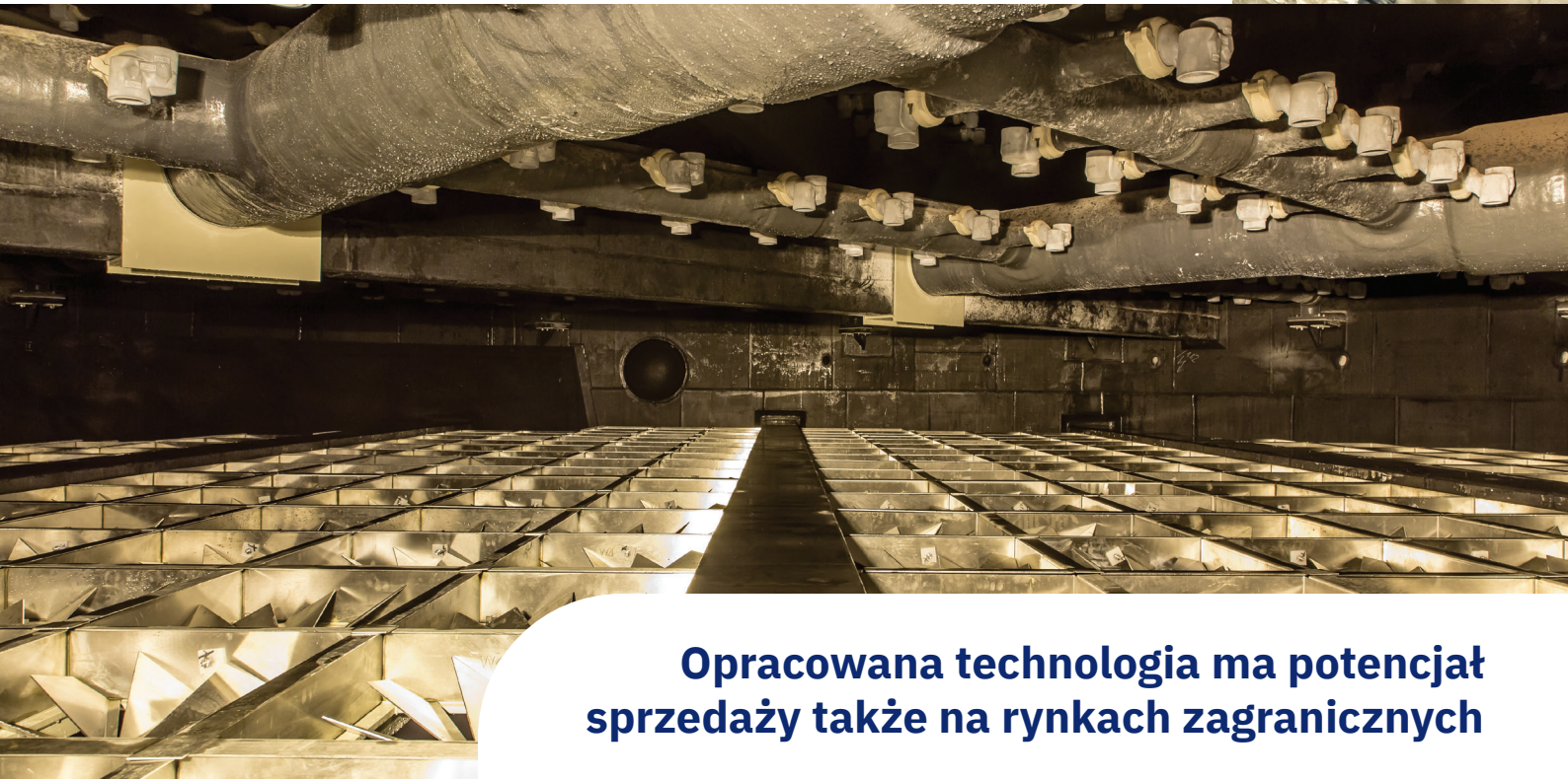
Widok półki z zawirowywaczami, zamontowanej w absorberze o średnicy około 16 metrów, z dna opróżnionego absorbera
