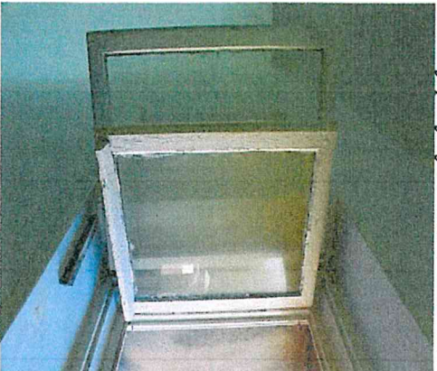
Oryginalne okno i okucie w ryzalicy skrzydła A
