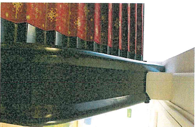
Krawędź ściany oprac. w formie pochwytu
