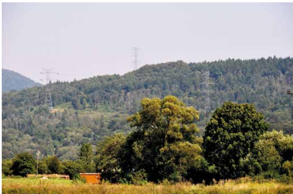
Ryc. 4.7. Okolice Przełęczy Dukielskiej. Dwutorowa napowietrzna linia elektroenergetyczna o napięciu 400 kV w terenie górskim. Usytuowanie słupów linii wpływa na jej widoczność a tym samym na oddziaływanie na krajobraz.
