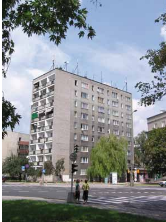
Ryc. 4.14. Stacja bazowa telefonii komórkowej na dachu bloku. Poziom pola elektromagnetycznego we wnętrzu budynku odpowiada poziomowi pola w jego otoczeniu.
