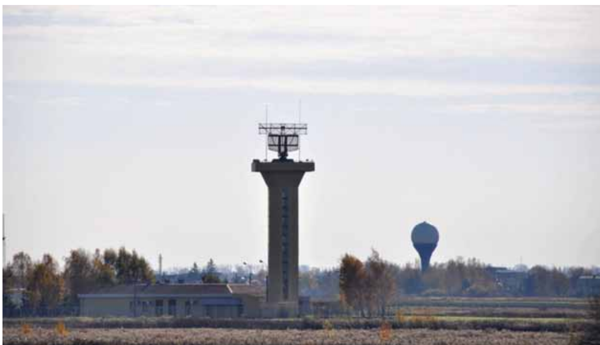
Ryc. 4.18. Stacje radiolokacyjne w otoczeniu lotniska na warszawskim Okęciu.
