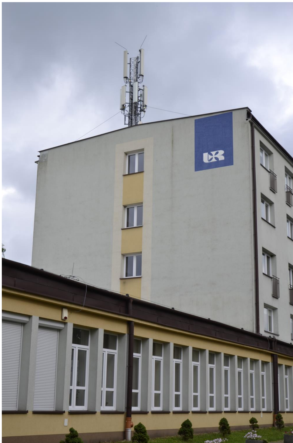
Fot. 1: Widok anten stacji bazowej ID: 58284 (20284N!), zlokalizowanej przy ul. Ćwiklińskiej 2 w Rzeszowie
