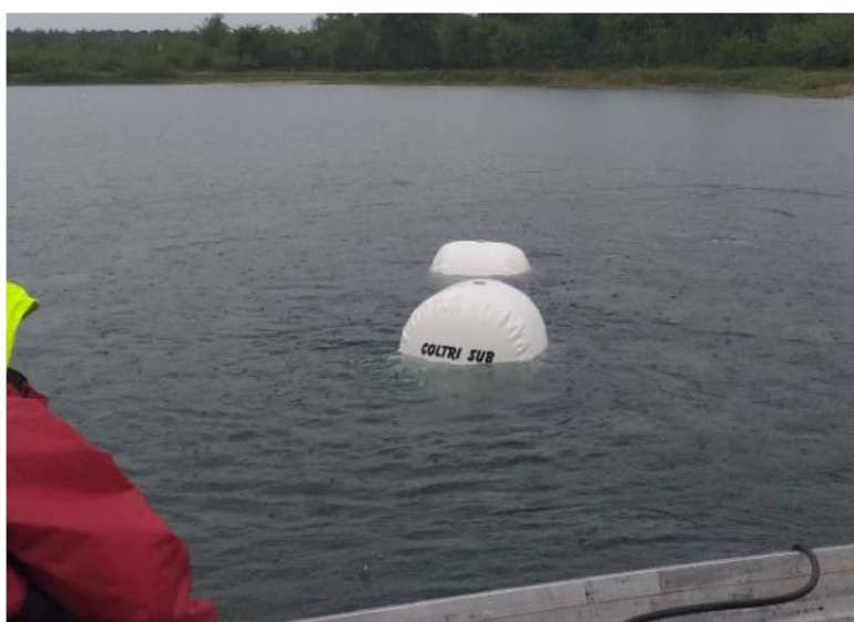
rys. 223 Wydobywanie obiektu na powierzchnię wody z zastosowaniem balonów wypornościowych Fot. SGRW-N „Małopolska”
