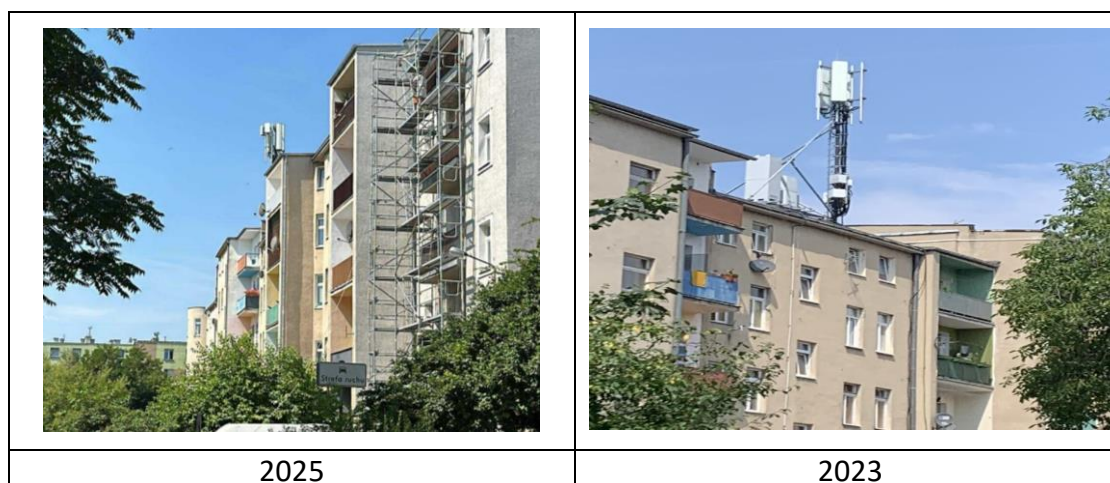
Rys. 4: Widok anten stacji bazowej – ID: OPO1008
