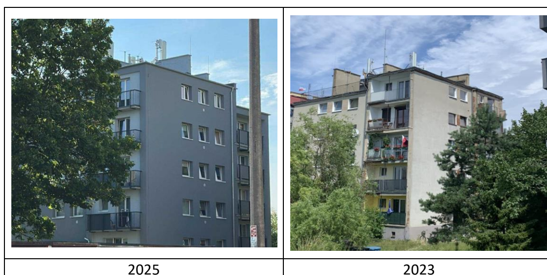
Rys. 8: Widok anten stacji bazowej – ID: OPO1537
