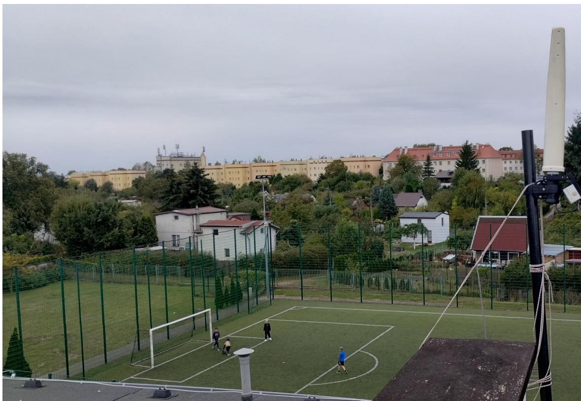
Rys. 3 Miejsce montażu SMS PEM – SP nr 53 w Szczecinie – widok na SBTK
