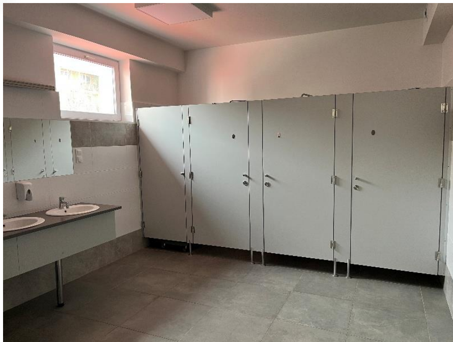
Zdjęcie 65 - Remont łazienki JRG Tarnobrzeg
