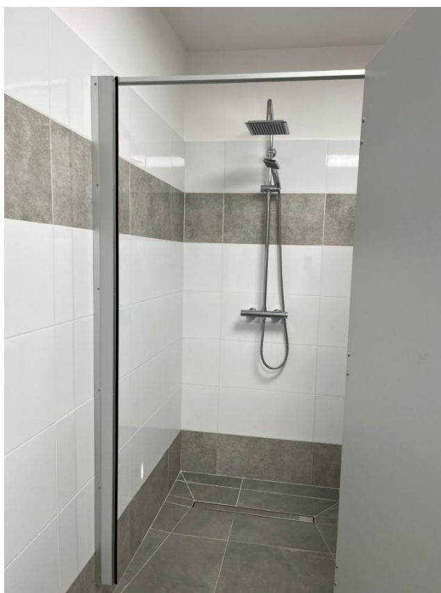
Zdjęcie 69 - Remont łazienki JRG Nowa Dęba
