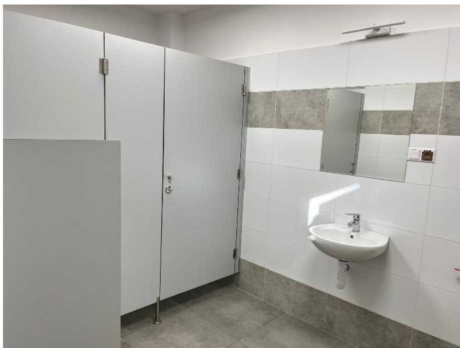
Zdjęcie 68 - Remont łazienki JRG Nowa Dęba
