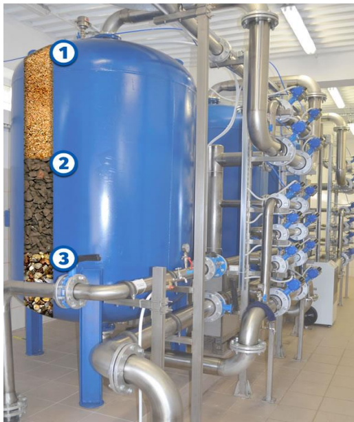
Rysunek 2. Przekrój zbiornika filtracyjnego z 3 różnymi złożami
