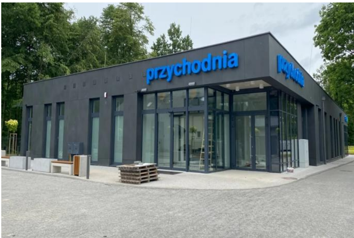
Budynek Przychodni Zdrowia z apteką w Wiązownie (źródło: https://www.przegladotwocki.pl/ )
