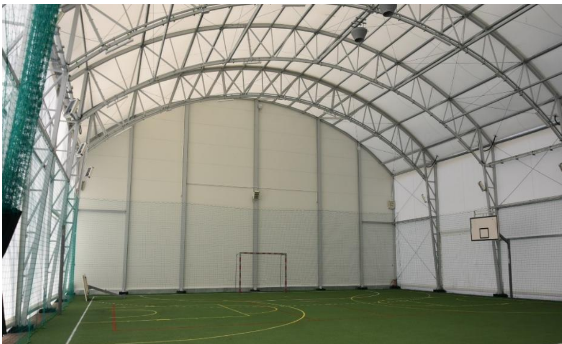
Zadaszenie boiska wielofunkcyjnego z zapleczem sanitarnym przy Szkole Podstawowej Nr 2 w Otwocku (źródło: PSSE Otwock)
