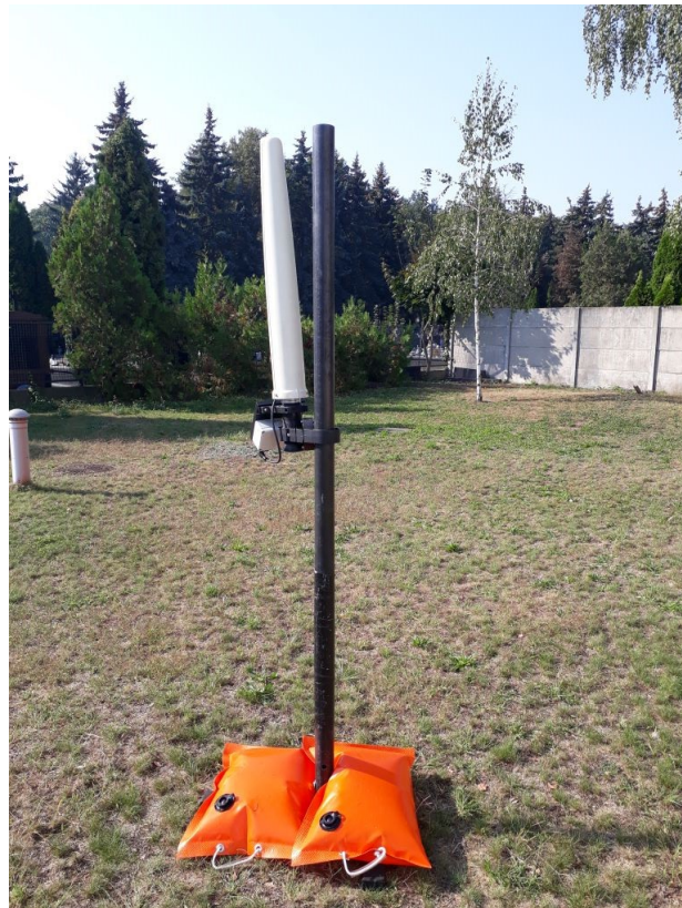
Rys. 2 Miejsce montażu SMS PEM – TBS Pruszków
