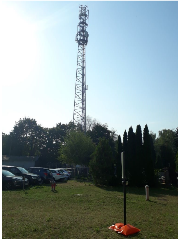
Rys. 3 Miejsce montażu SMS PEM – TBS Pruszków – widok na SBTK
