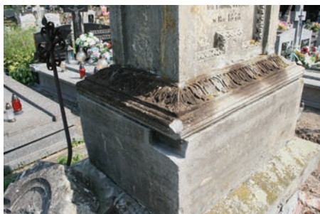
3. Ostrożany. Nagrobek Józefa Bieżańskiego przed podjęciem prac konserwatorskich. Fragment. Fot. M. Andron
