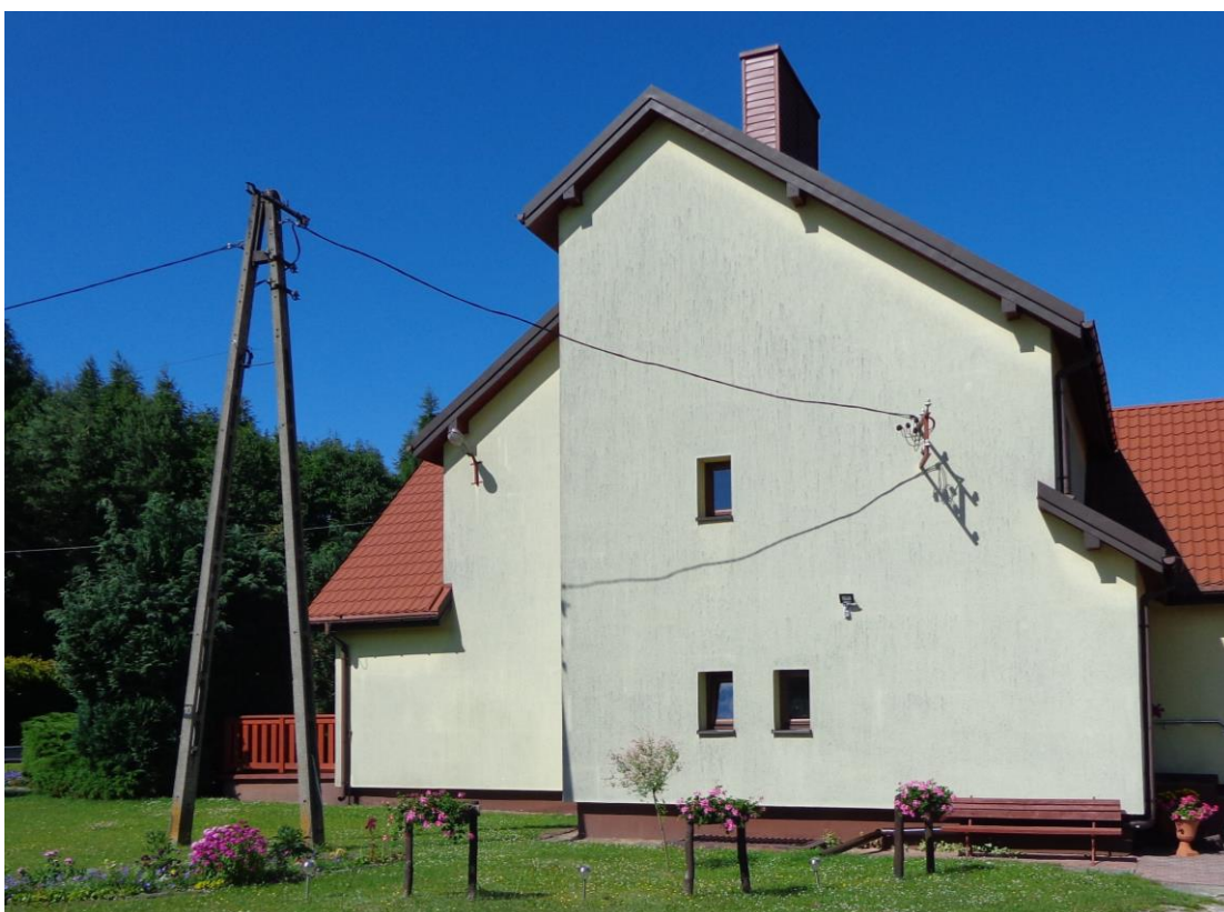
Fot.2. Elewacja szczytowa.
