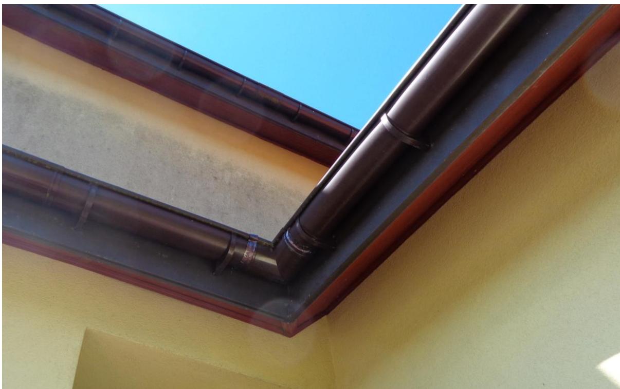
Fot.4. Uszczelnienie rynien na narożu koszowym dachu.
