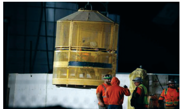
► Rys. 9. Ewakuacja pracowników z wykorzystaniem kapsuły transportowej podwieszonej do dźwigu
