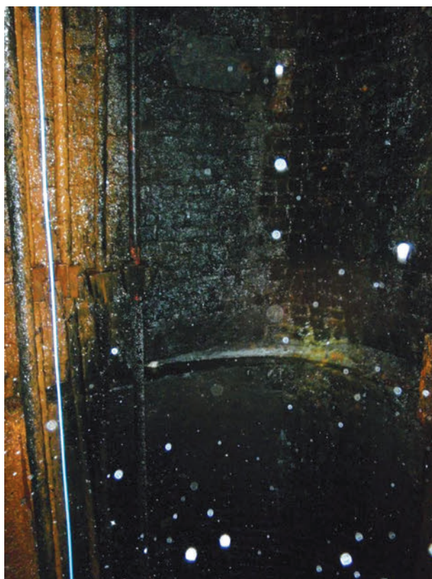
► Rys. 2. Widok ociosu szybu na odcinku przejścia na przekrój owalny
