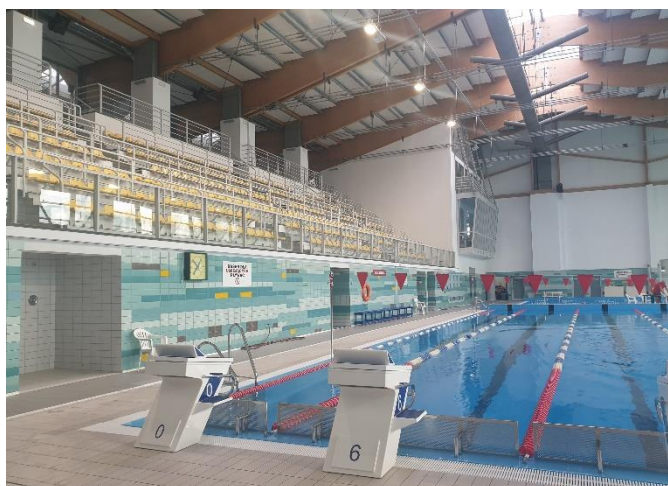
Zdjęcie: Płyvalnia Akademii Wychowania Fizycznego przy ul. Mikołowskiej 72a po remoncie.
