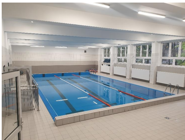
Zdjęcie: Płyvalnia w Szkole Podstawowej Nr 10 przy ul. Sokolskiej 23 po remoncie.
