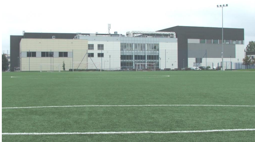
Fot. 1a, b: Widoki anten stacji bazowej: ID: BYD1038A zlokalizowanej przy ul. Sportowej 2 w Bydgoszczy
