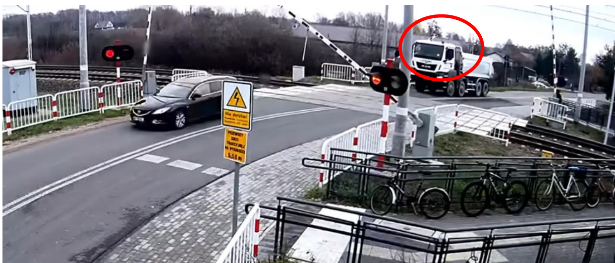
Zdjęcie 7 – Widok z kamery od strony napędu N1 w trakcie wjazdu na przejazd kolejowy samochodu ciężarowego i wygięcie rogatek (źródło: PKP PLK S.A.).
