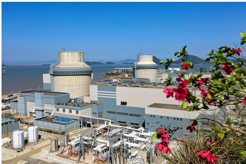
Fot. 6. Ogólny widok ukończonych bloków 1 i 2 Elektrowni Jądowej Sanmen (źródło: Westinghouse Electric Company).
