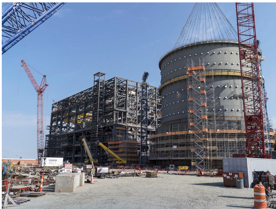
Fot. 12. Blok Summer 2 na krótko przed przerwaniem budowy w 2017 r. (źródło: South Carolina Electric & Gas).
