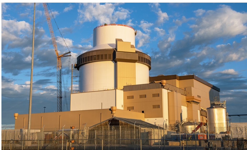
Fot. 11. Końcowa faza budowy bloku Vogtle 4 – zdjęcie ze stycznia 2023 r. (źródło: Georgia Power Company).
