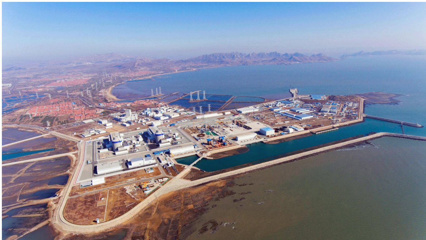
Fot. 8. Teren Elektrowni Jądrowej Haiyang. Z lewej ukończone bloki 1 i 2 na bazie technologii AP1000, na prawo od nich plac budowy bloków 3 i 4, które będą oparte już o chińską wersję CAP1000 (źródło: Westinghouse Electric Company).
