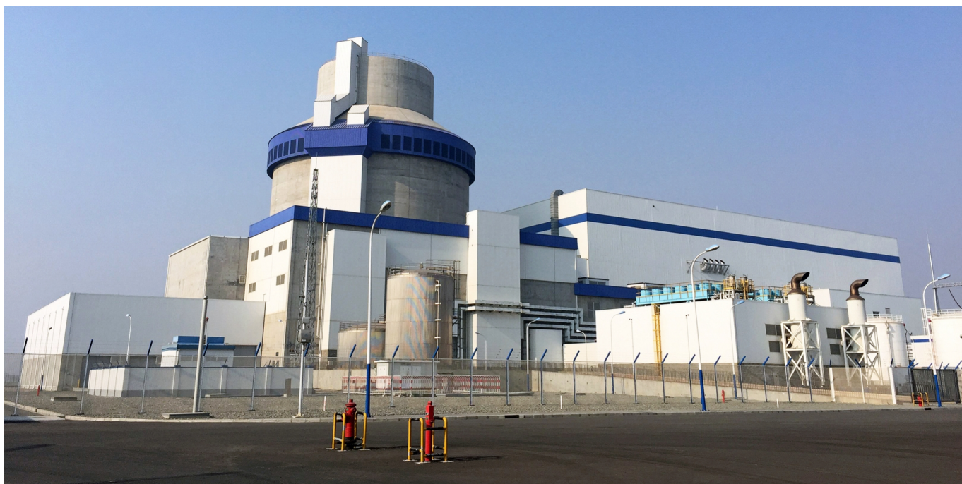
Fot. 9. Zabudowania bloku 1 EJ Haiyang. Z prawej strony widoczny budynek agregatów prądotwórczych napędzanych silnikami wysokoprężnymi (źródło: Westinghouse Electric Company).
