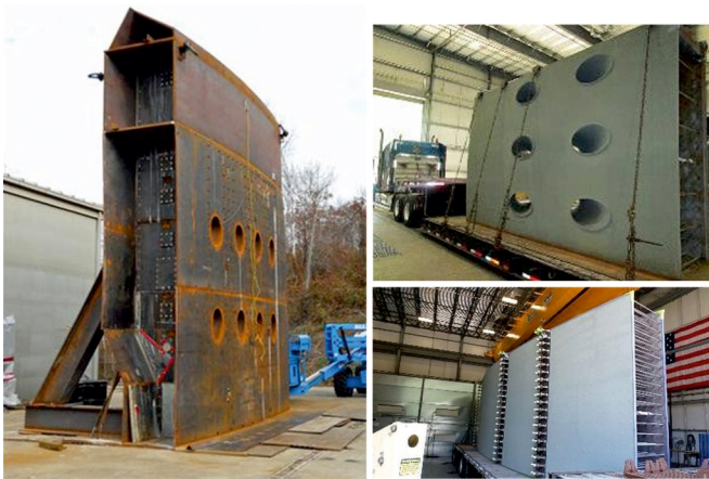
Fot. 3. Przygotowanie prefabrykatów do budowy zewnętrznych ścian budynku reaktora bloku AP1000 (źródło: Westinghouse Electric Company, [7]).
