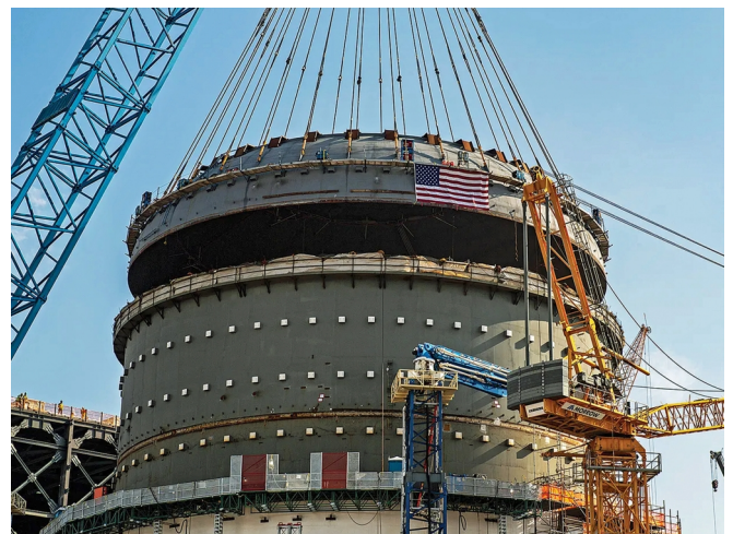
Fot. 4. Opuszczanie dźwigiem górnej kopuły metalowej obudowy bezpieczeństwa budynku reaktorowego AP1000 bloku Vogtle 3 (źródło: Westinghouse Electric Company).
