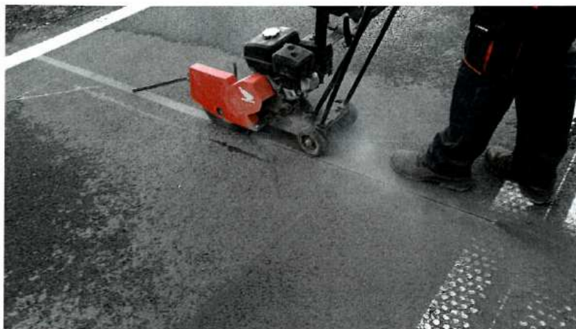
Rysunek 3 Wycinanie rowków na sensory wagowe
