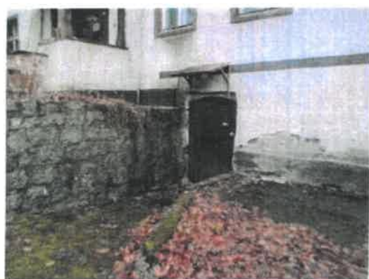
Wejście do piwnic
