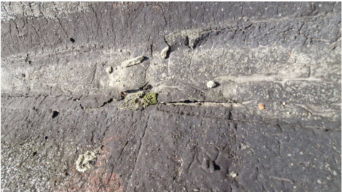
Koryto odwodnieniowe wieży, nieszczelności pokrycia
