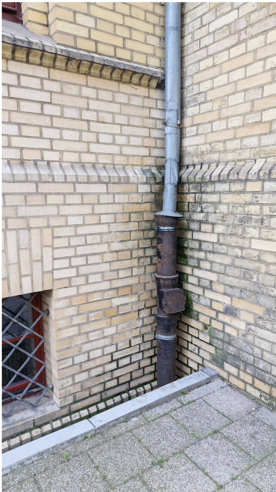
Istniejące rury spustowe
