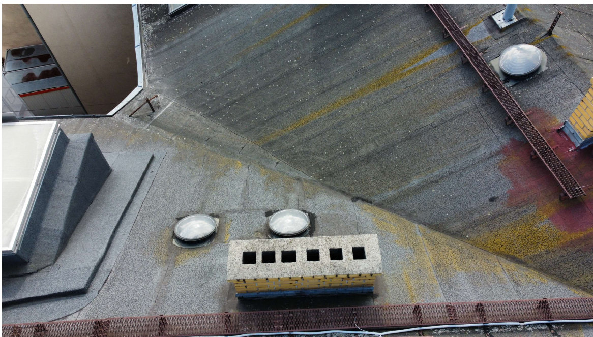
Widok połaci południowej oraz wschodniej
