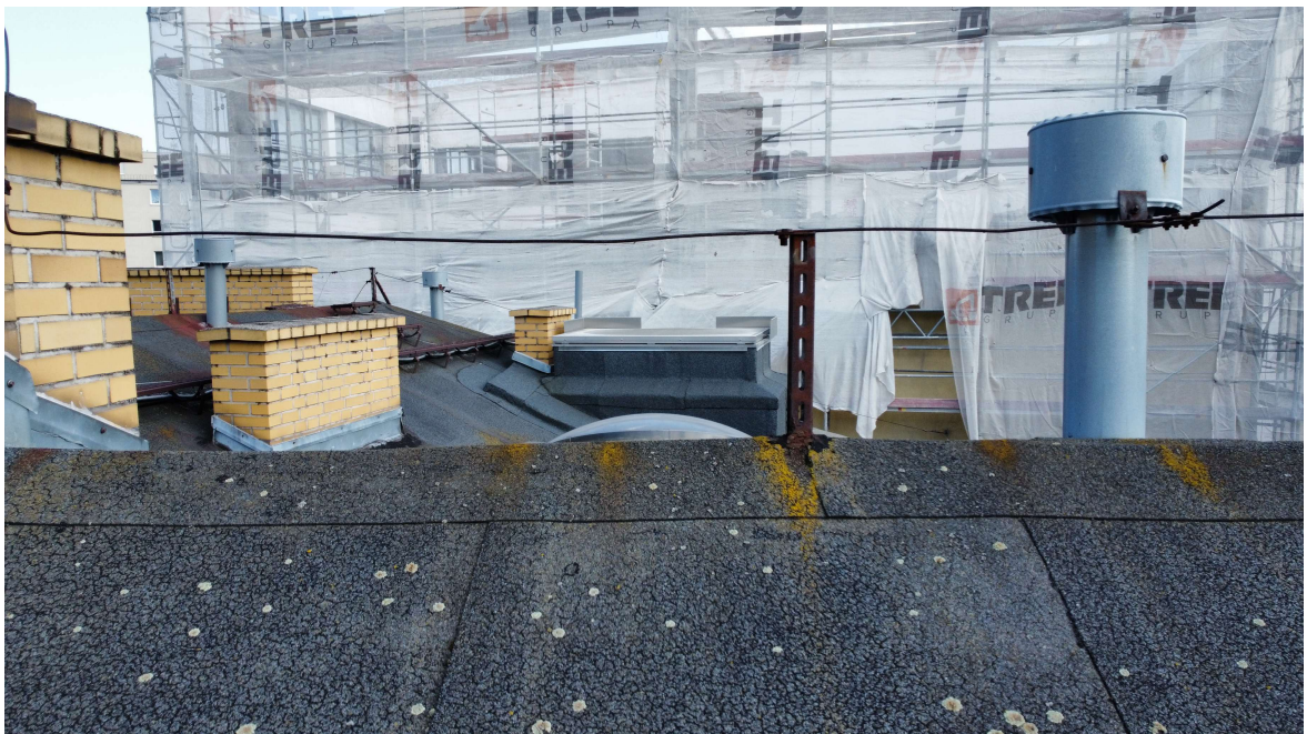
Instalacja odgromowa oraz spękania papy
