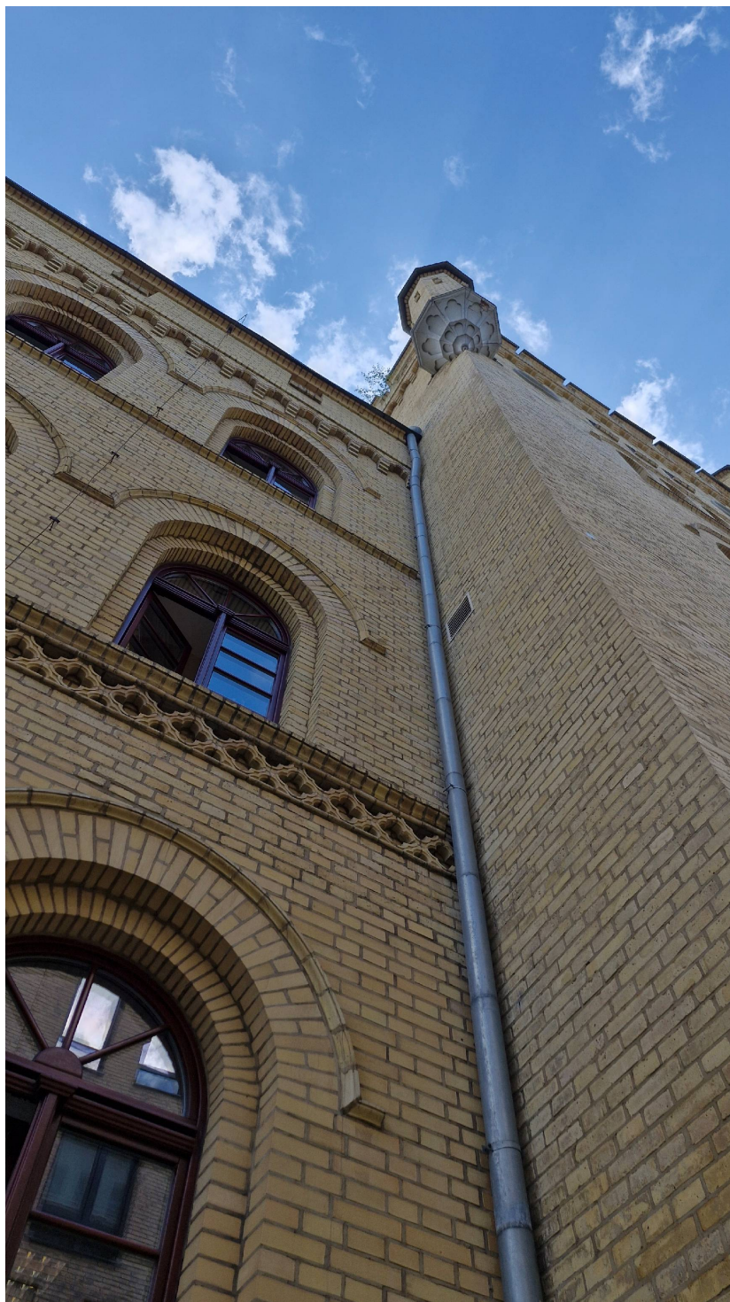
Istniejące rury spustowe
