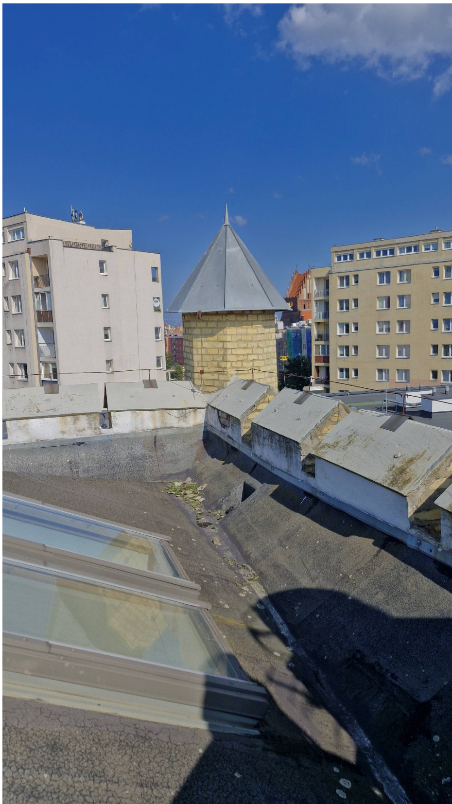
Koryto odwodnieniowe wieży
