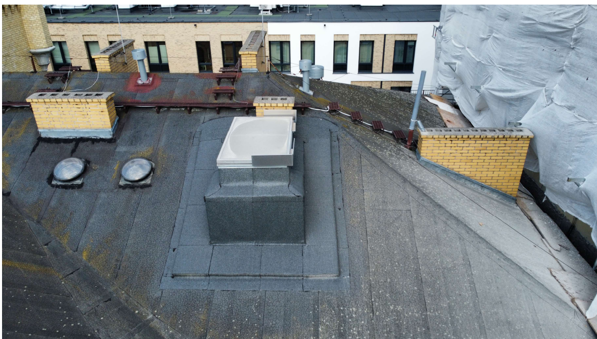
Widok połaci południowej
