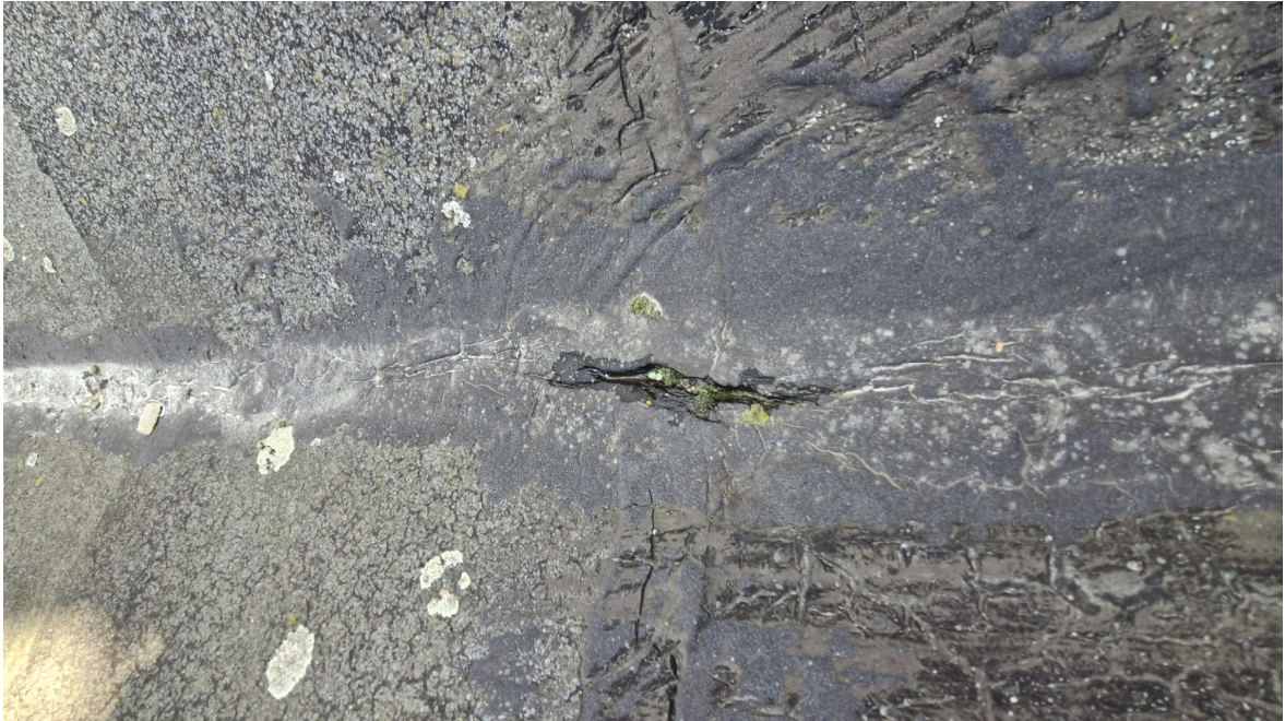
Koryto odwodnieniowe wieży, nieszczelności pokrycia
