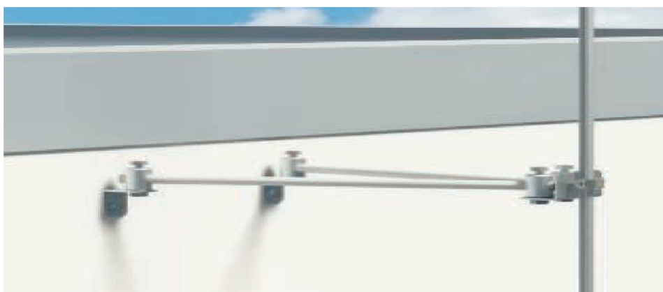
Rys. 4. Maszt zrealizowany z wykorzystaniem elementów izolowanych i kątowników montażowych.
