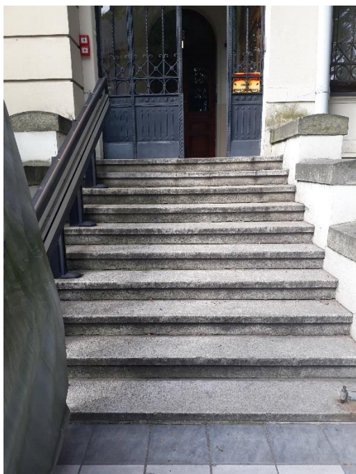
Fotografia 6. Widok biegu schodowego górnego (część zabytkowa).
