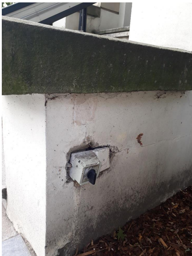
Fotografia 3. Istniejący włącznik ogrzewania schodów.
