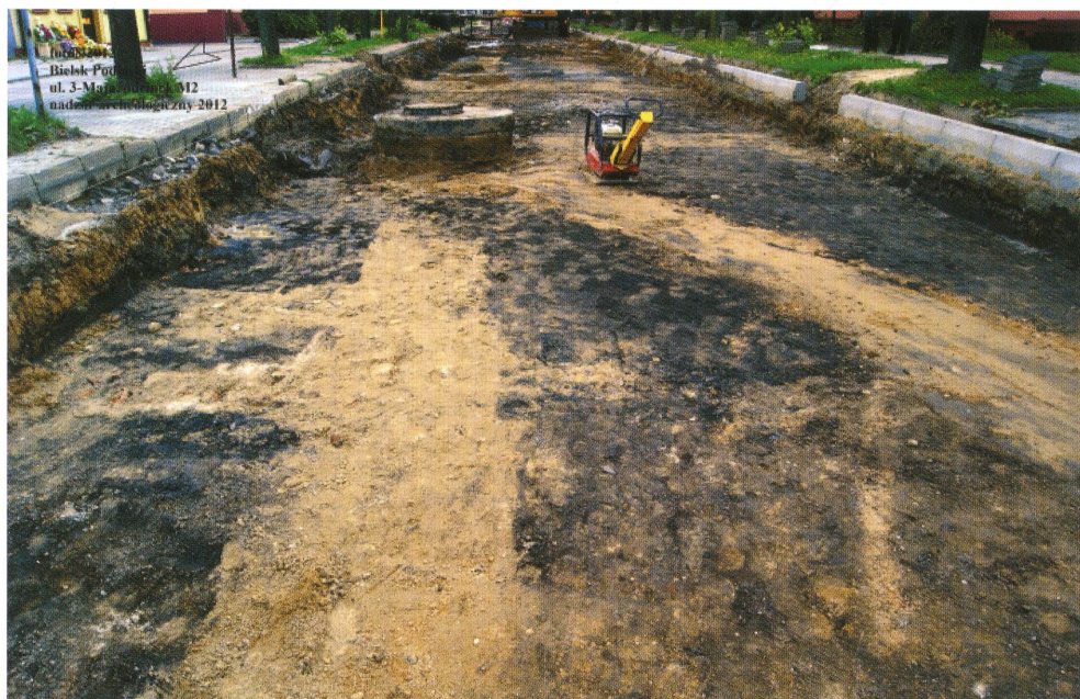
10. Bielsk Podlaski. Układ warstw na poziomie korytowania ul. 3 Maja. Fot. L. Pawlata. Bielsk Podlaski. Configuration of strata upon the level of trenching 3 Maja Street. Photo: L. Pawlata.
