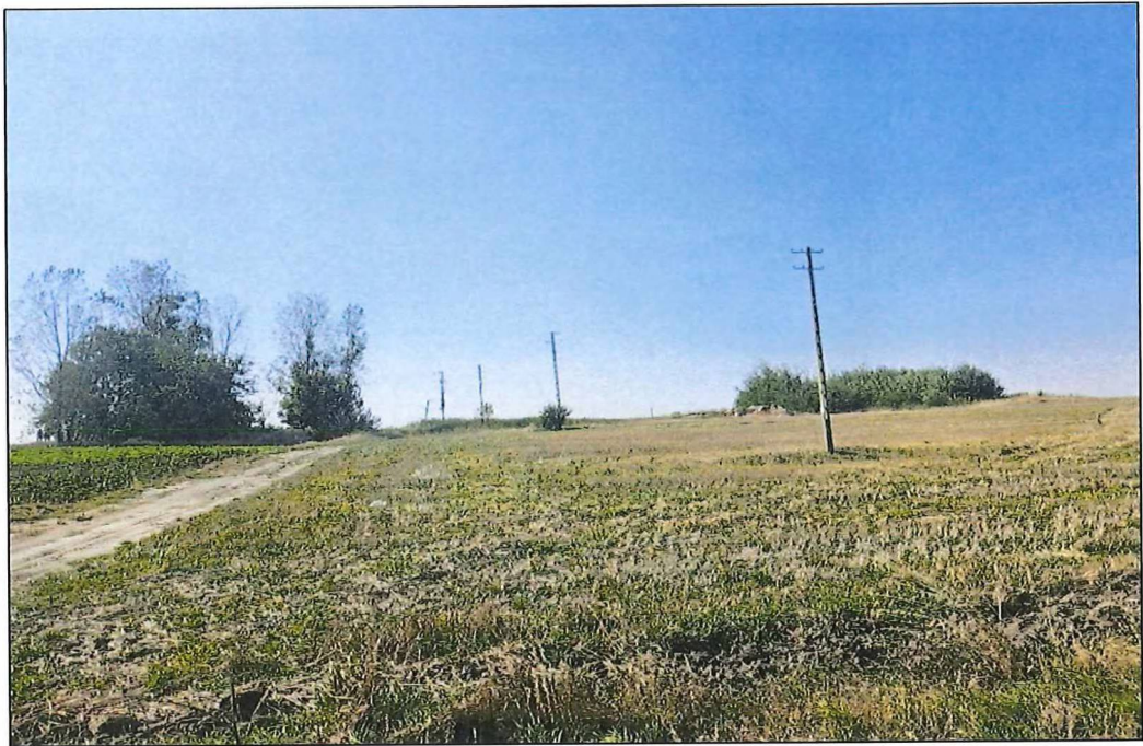
21. Napowietrzna linia energetyczna po zachodniej stronie drogi Cześniki – Wolica Śniatycka, fot. Piotr mazur, wrzesień 2024 r.
