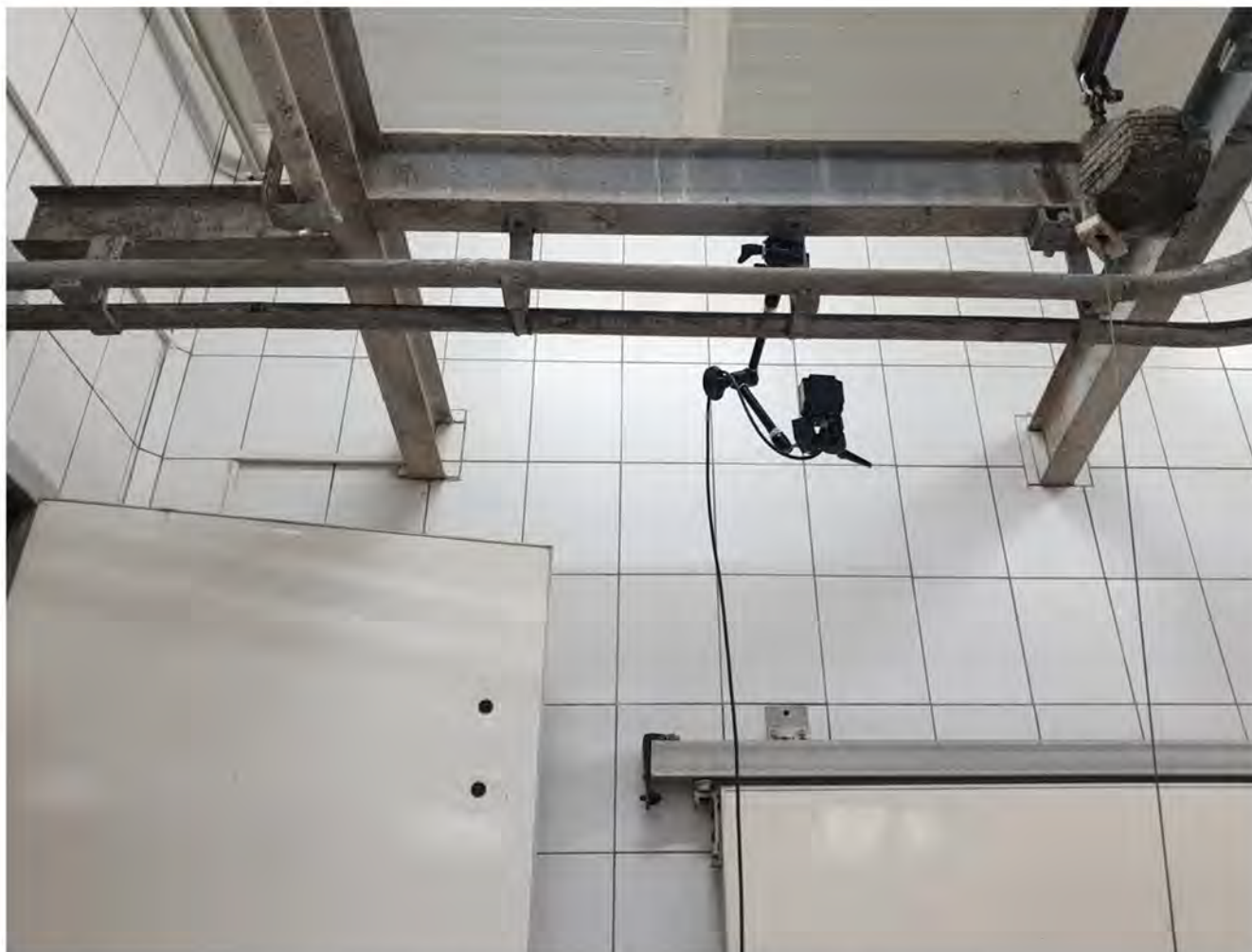
Rysunek 32 Miejsce instalacji anteny RFID przed wjazdem na halę rozbiorową
