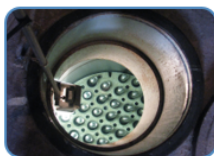
Przechowalnik wypalonego paliwa jądrowego - obiekt nr 19
