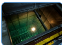
Przechowalnik wypalonego paliwa jądrowego - obiekt nr 19a
