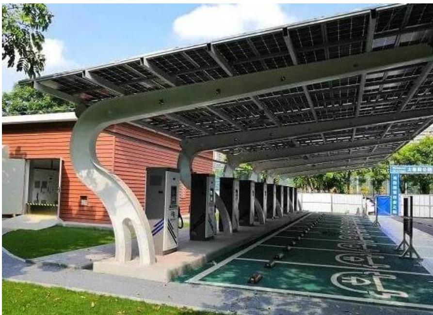
Obrázek 14: Vzor kombinace FVE a nabíječek pro osobní vozidla, kola, koloběžky
