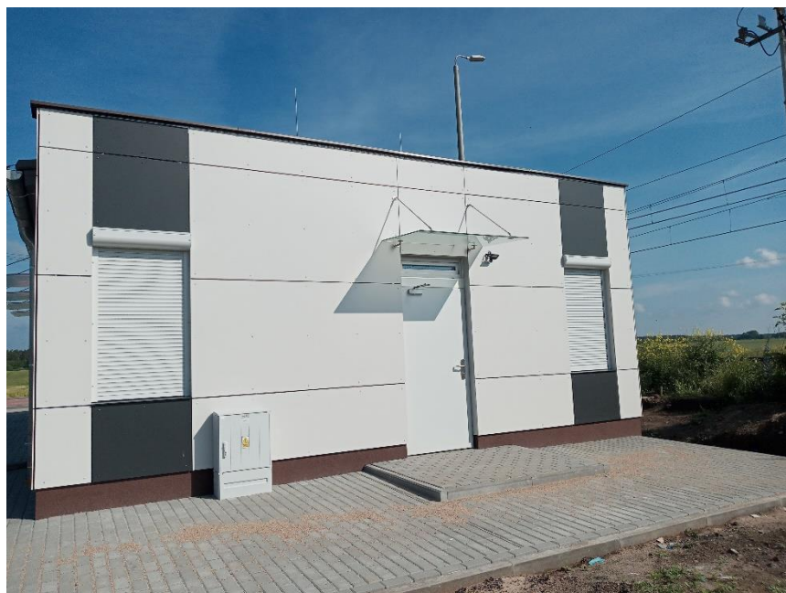
2. Budynek socjalno-magazynowy PKP w Dobiegniewie
