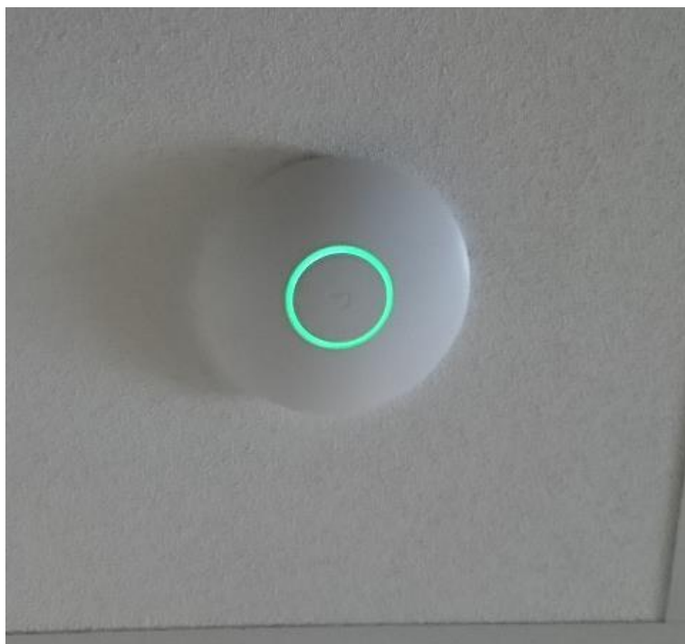
Fot. 8: Widok punktu dostępowego model UniFi – UAP
