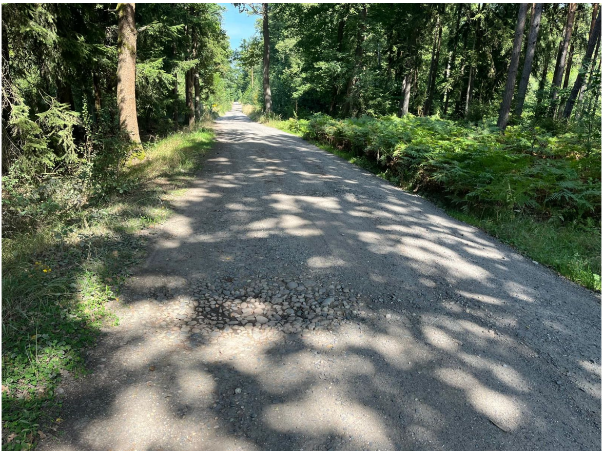
Zdjęcie nr 1 i 2 – droga nr 132
