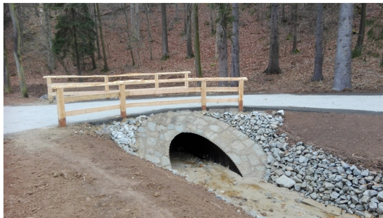
Bród i przepust w Leśnictwie Dobromierz
