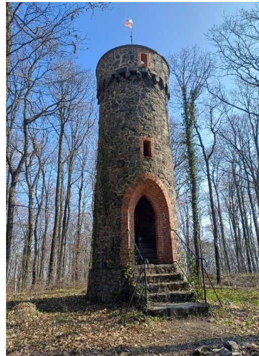
Wieża Bazaltowa Góra
