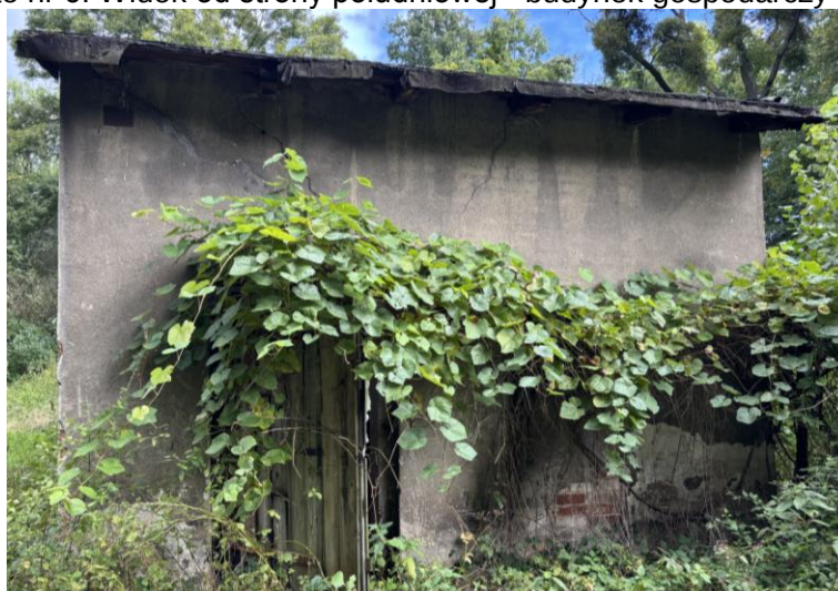
Foto nr 7. Widok od strony południowej - budynek gospodarczy nr 3.
