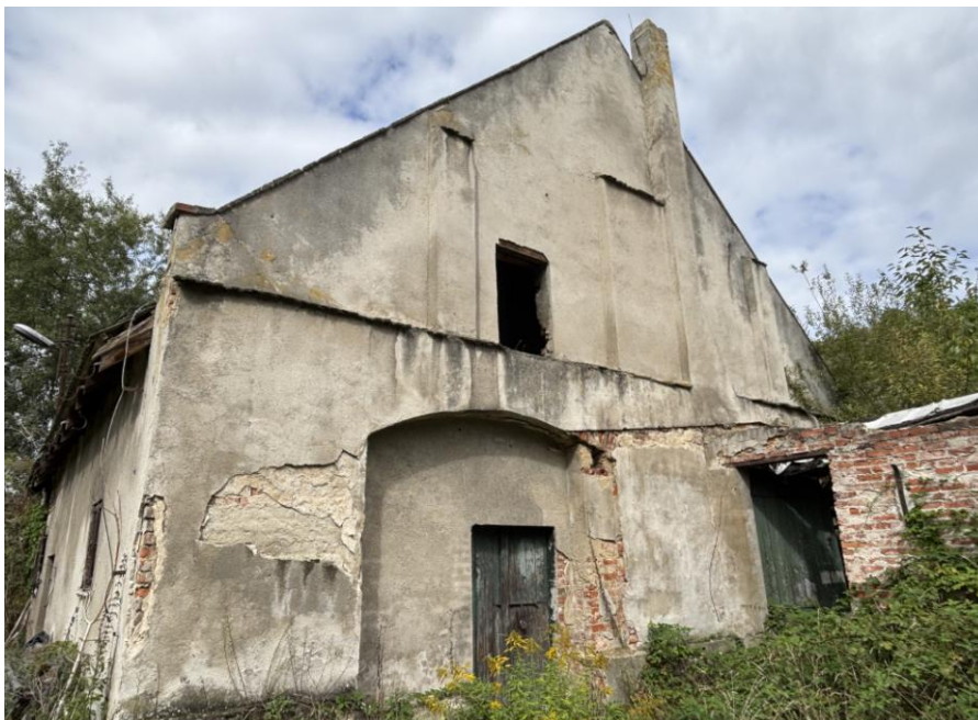
Foto nr 3. Widok od strony wschodniej - budynek gospodarczy nr 1.
