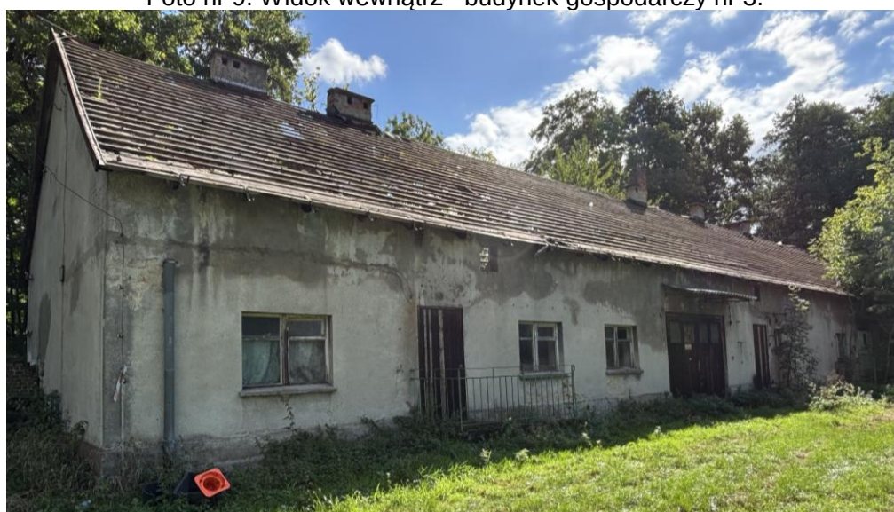
Foto nr 10. Widok od strony zachodniej - budynek gospodarczy nr 4.
