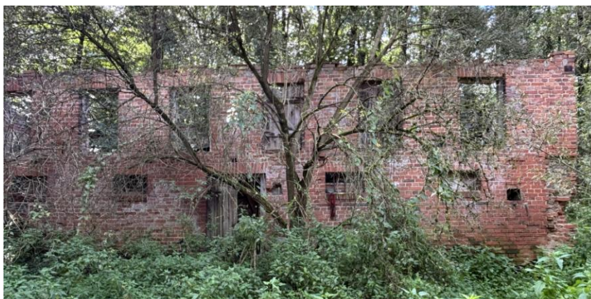
Foto nr 12. Widok od strony północnej - budynek gospodarczy nr 5.
