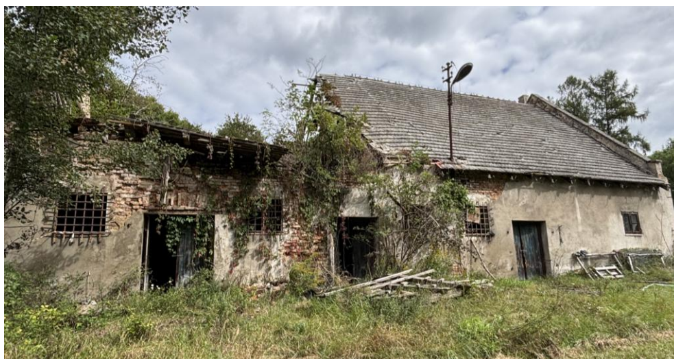
Foto nr 2. Widok od strony południowej - budynek gospodarczy nr 1.
