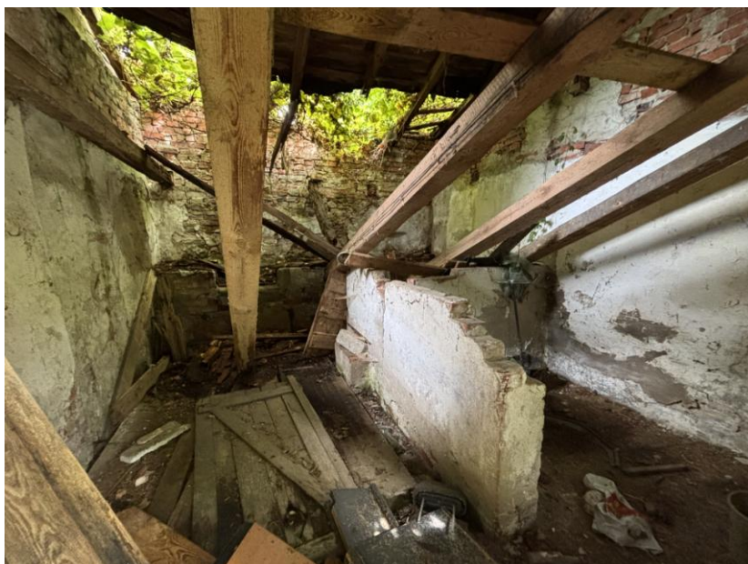
Foto nr 9. Widok wewnątrz - budynek gospodarczy nr 3.
