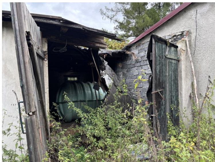
Foto nr 6. Widok od strony południowej - budynek gospodarczy nr 2.
