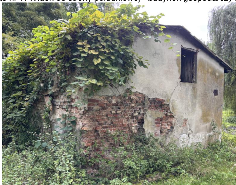
Foto nr 8. Widok od strony zachodniej - budynek gospodarczy nr 3.
