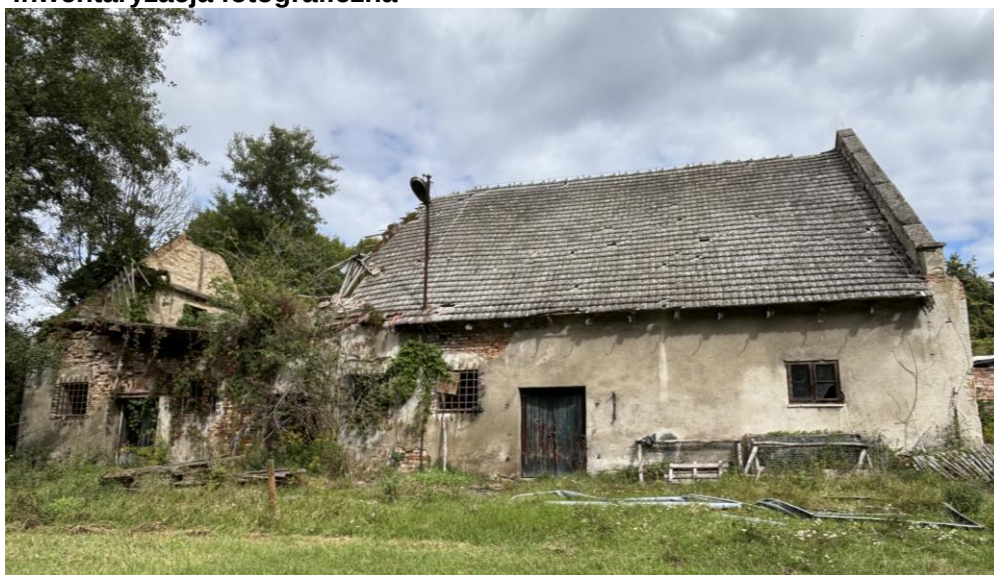
Foto nr 1. Widok od strony południowej - budynek gospodarczy nr 1.
