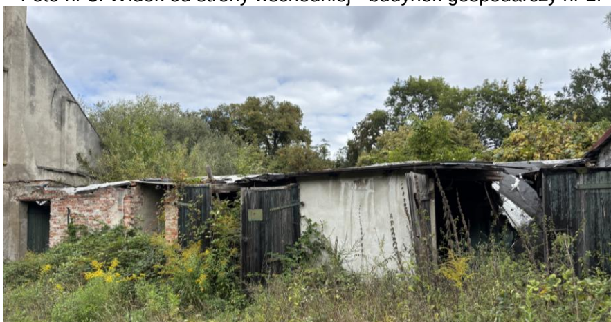
Foto nr 4. Widok od strony południowej - budynek gospodarczy nr 2.
