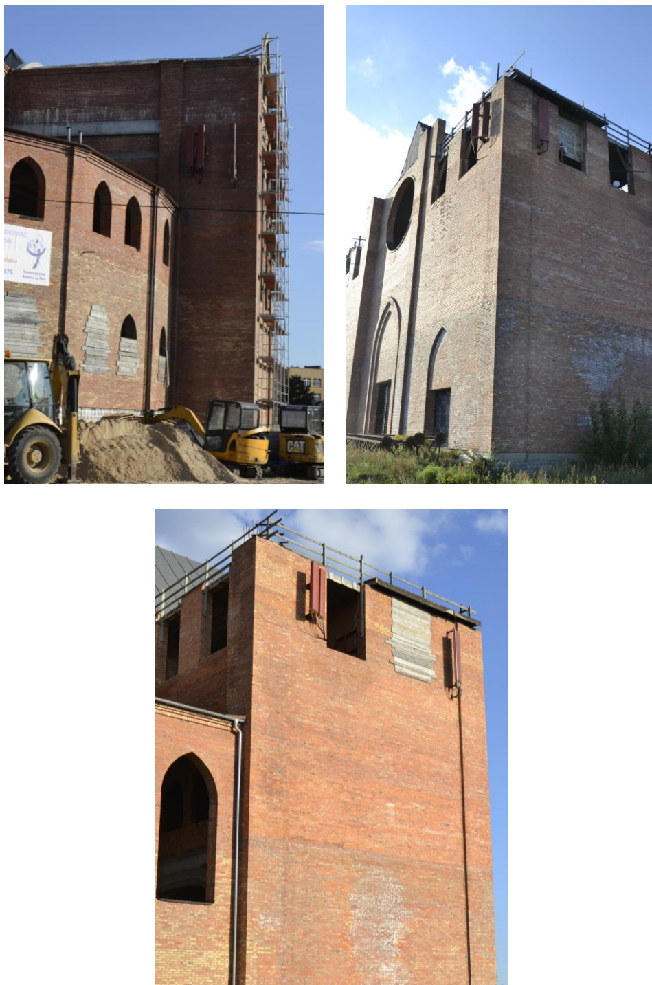
Fot. 1a, b, c: Widoki anten stacji bazowych ID: BIA1107B oraz ID BT13225, zlokalizowanych przy ul. NMP Królowej Rodzin 3 w Białymstoku
