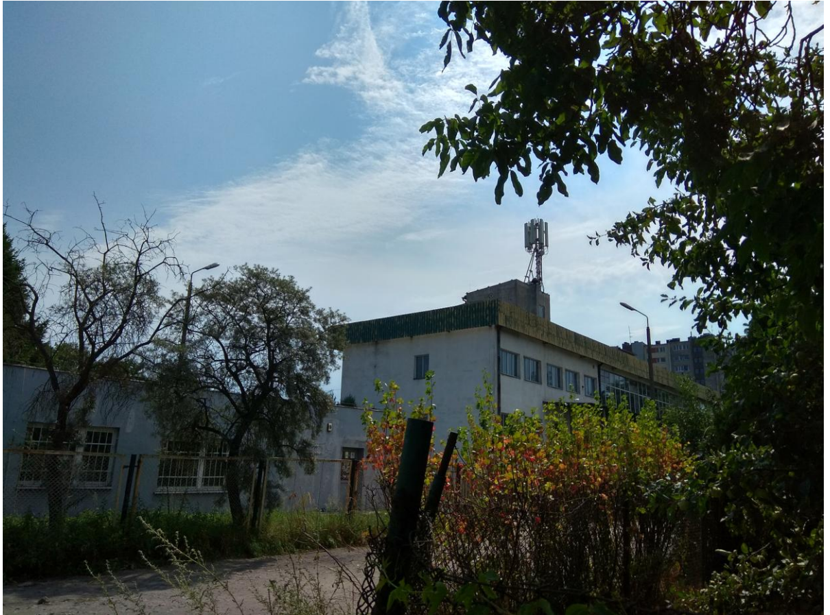
Fot. 1: Widok anten stacji bazowej ID OPO1027_D, zlokalizowanej przy ul. Nowowiejskiego 19 w Opolu
