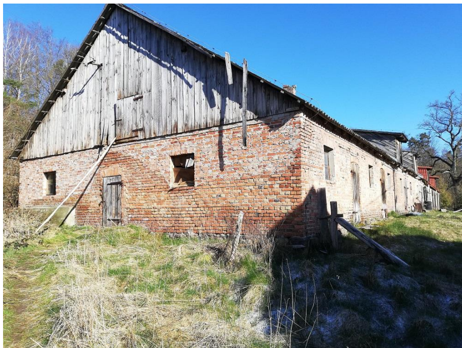
Fot. 2. Budynek od strony południowo-wschodniej
