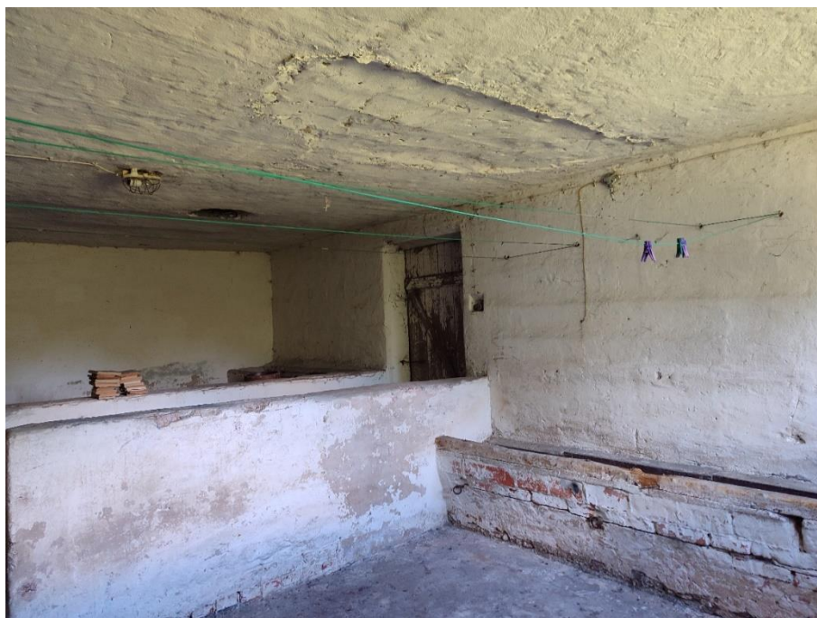
Fot. 7. Zabudowa wewnętrzna w budynku
