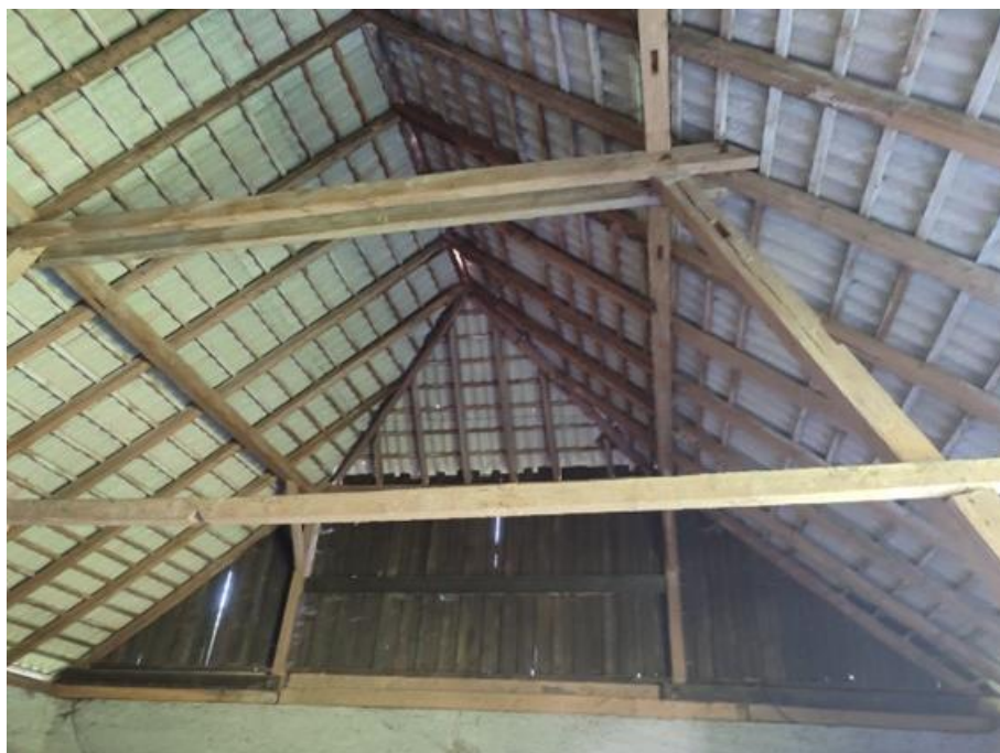
Fot. 3. Konstrukcja i pokrycie dachu – widok od wewnątrz.
