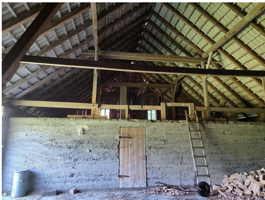
Fot. 5. Zabudowa wewnętrzna w budynku.
