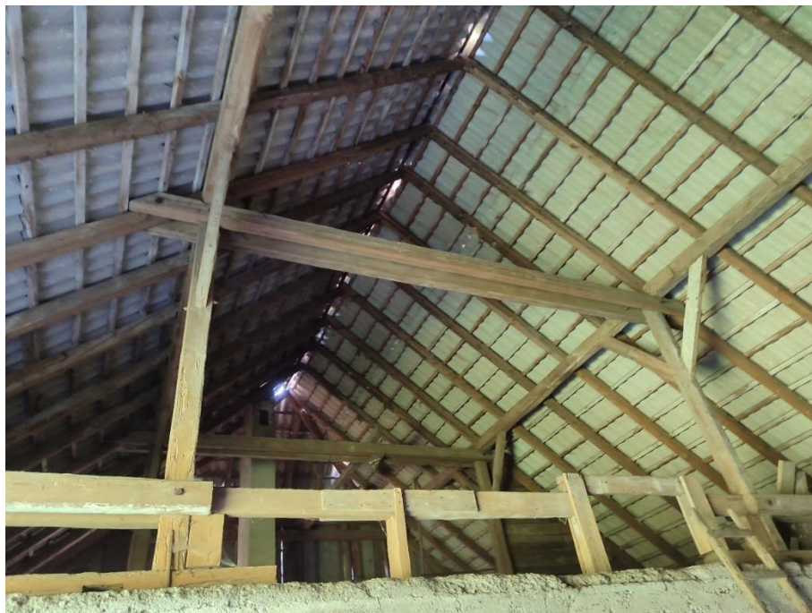
Fot. 4. Konstrukcja i pokrycie dachu – widok od wewnątrz.
