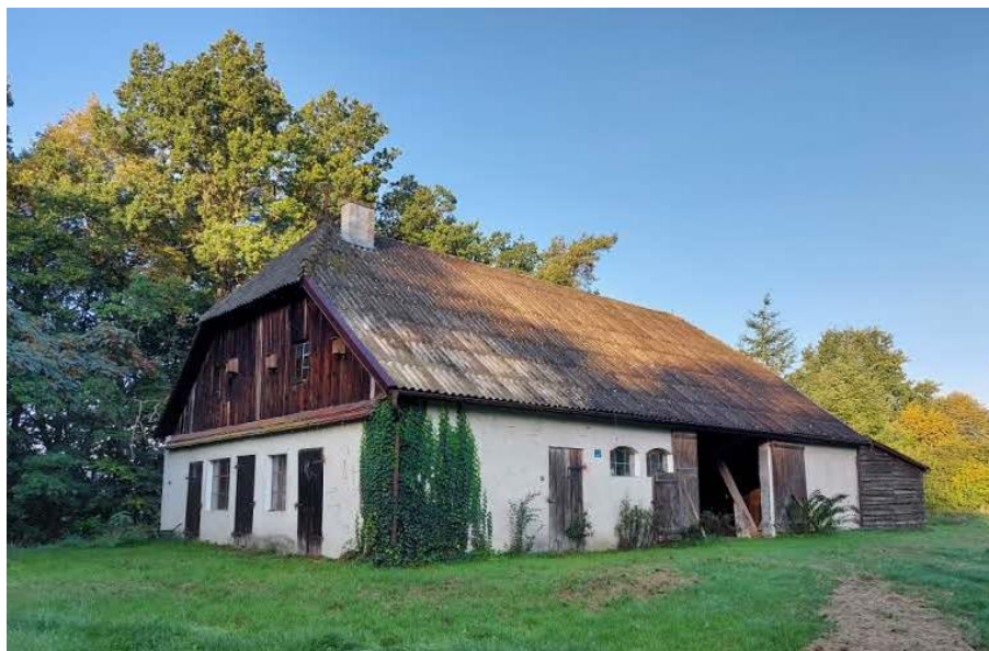
Fot. 1. Budynek od strony frontowej (wschodniej).
