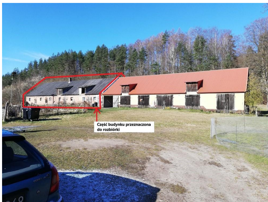
Fot. 1. Budynek – część nr inw. 108/00142A (przeznaczona do rozbiórki) i nr inw. 108/00142B (do dalszego użytkowania) – widok od strony frontowej (wschodniej).
