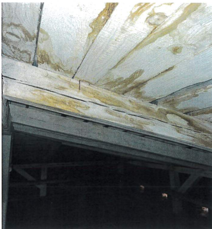
Fot.13. Widok deskowania i krokwi zacieki na całej powierzchni.
