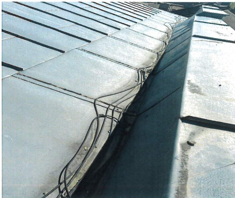
Fot.9. Widok nie działającego kabla grzewczego.
