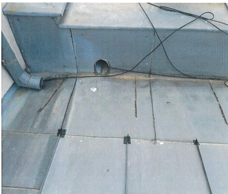
Fot.10. Widok nie działającego kabla grzewczego do rynien, mocowania kabla z gorszej jakości blachy widoczne zacieki rdzy, (mimo to kable jednak są nie zamocowane) Widok napraw na połaci dachu taśmą dekarską.
