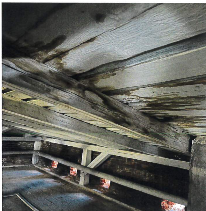
Fot.14. Widok deskowania i krokwi zacieki na całej powierzchni.
