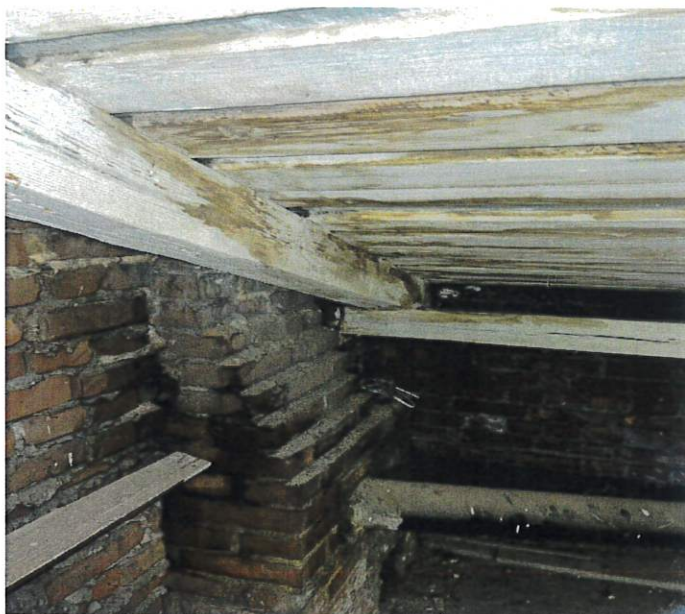
Fot.14. Widok narożnika-zacieki deskowanie całej powierzchni, krokwie i płatew
