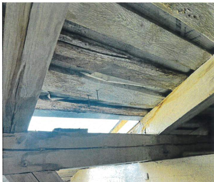
Fot.18. Widok deskowania - zacieki na całej powierzchni (widoczne mocowanie blachy -haftry)
