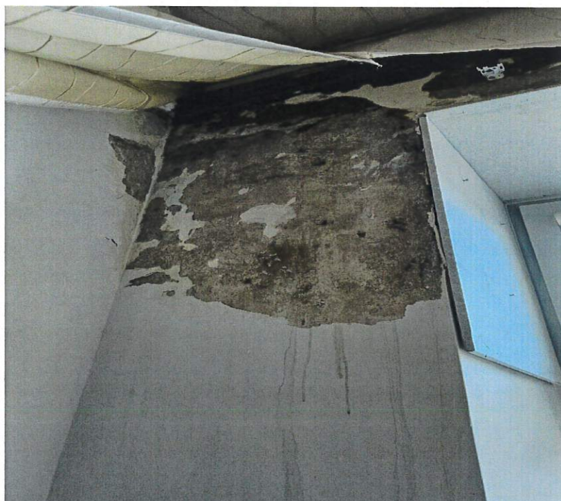
Fot.4. Widok narożnika od wewnątrz (skutki penetracji wody w pomieszczeniu sekretariatu)
