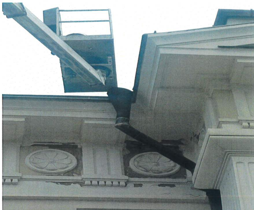
Fot.3. Widok narożnika od zewnątrz (skutki penetracji wody, niszczenie rozet, krokwytyn, fryz)
