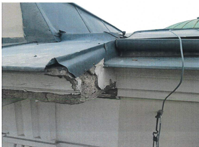
Fot.6. Widok obróbki blacharskiej gzymsu wieńczącego (odspojony tynk wieńca)
