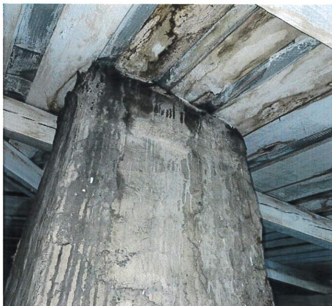
Fot.17. Widok deskowania - zacieki przy kominie. (deskowanie mocowane z prześwitem, widoczna membrana dachowa)
