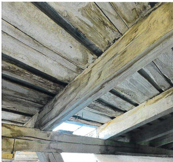
Fot.15. Widok deskowania, krokwi, płatwi –zacieki na całej powierzchni i konstrukcji.
