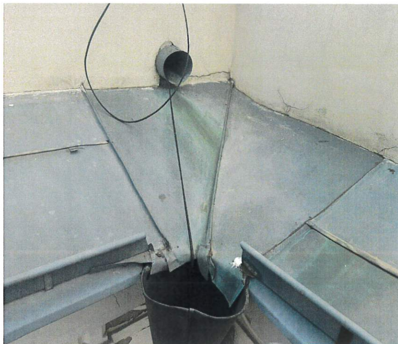
Fot.5. Widok obróbki blacharskiej do rury spustowej (przy ścianie attykowej)
