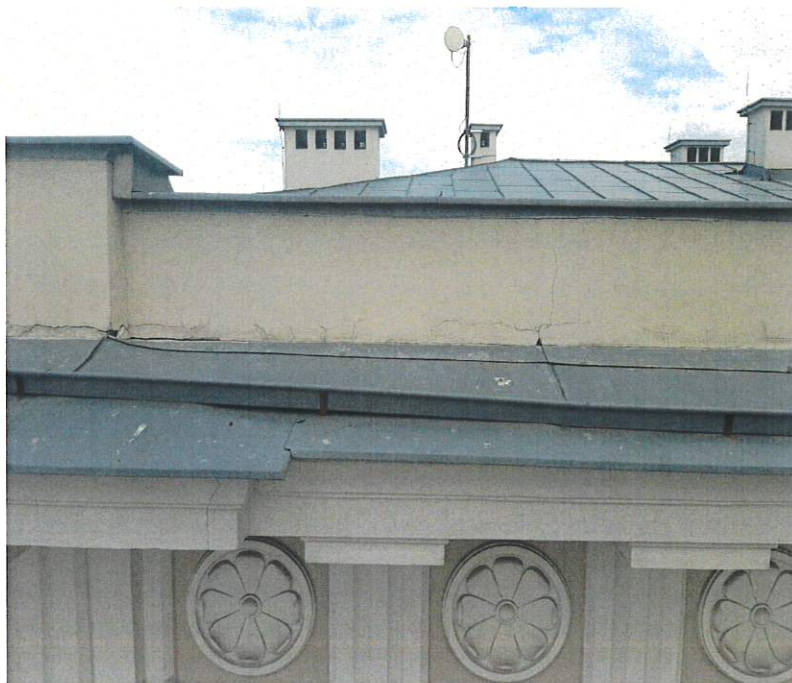
Fot.7. Widok obróbki blacharskiej gzymsu wieńczącego (zarysowania ściany kolankowej)
