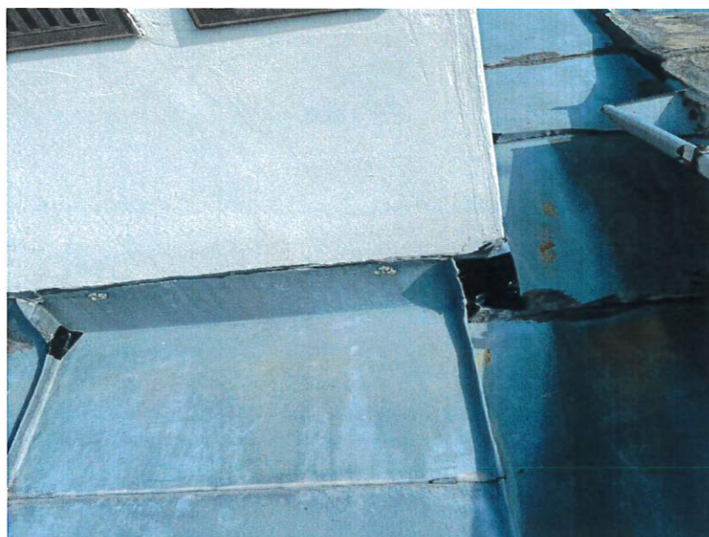
Fot.8. Widok naprawianej obróbki blacharskiej komina (taśmą dekarśką)
