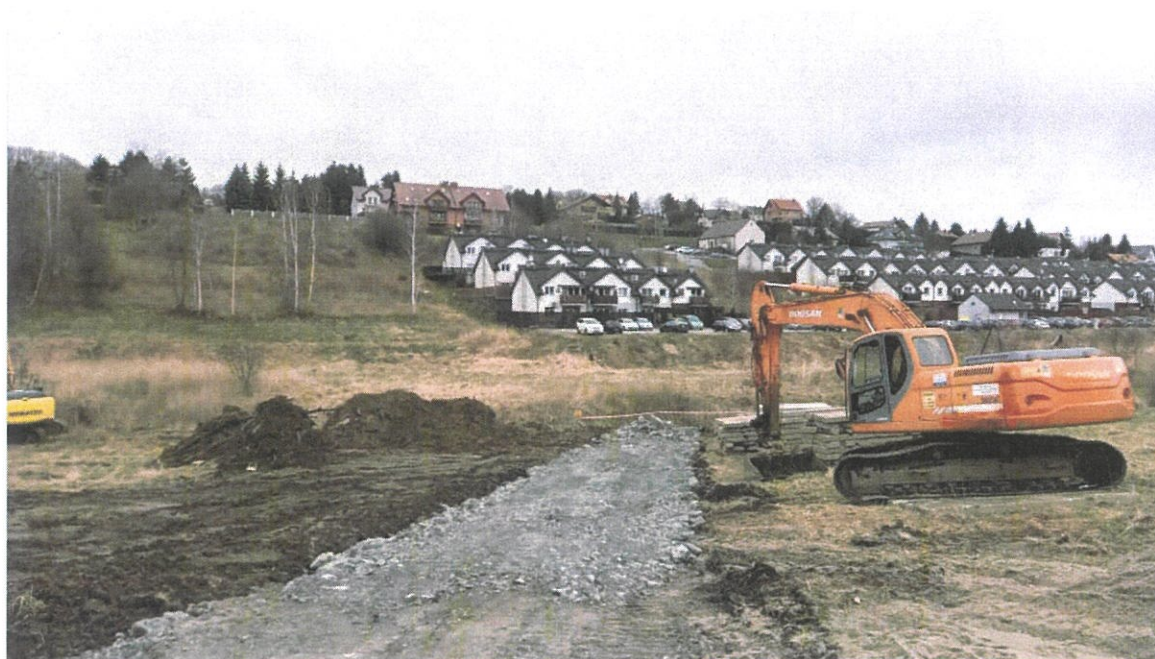
Foto. 13. Budowa drogi technologicznej do miejsca budowy zapory czołowej zbiornika, stan w trzeciej dekadzie lutego 2024 r. (widok w kierunku północnym).
