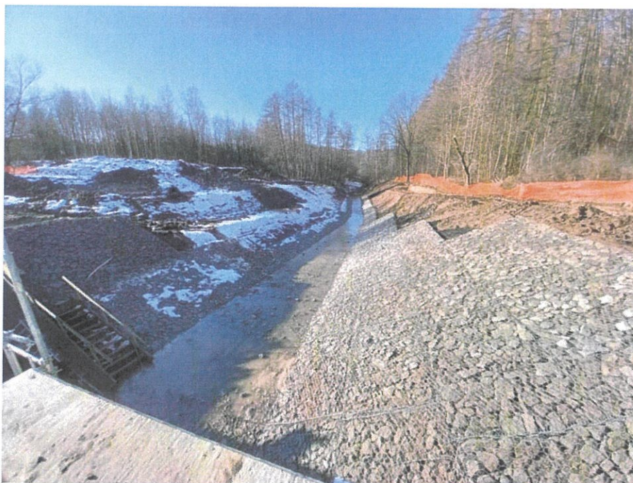
Foto. 53. Ubezpieczenie koryta potoku Malinówka poniżej budowli zrzutowej zbiornika, stan w trzeciej dekadzie stycznia 2025 r. (widok w kierunku zachodnim).
