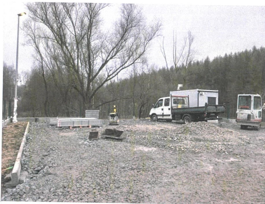
Foto. 47. Budowa placu manewrowego przy zaporze czołowej zbiornika, stan w pierwszej dekadzie kwietnia 2025 r. (widok w kierunku zachodnim).
