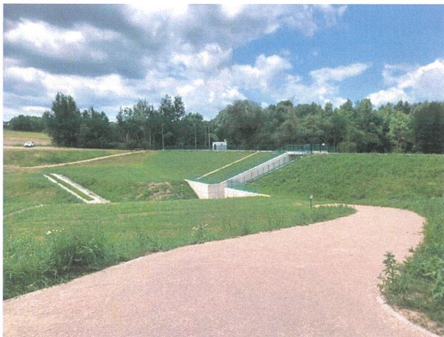
Foto. 46. Teren budowy zapory czołowej i budowli zrzutowej zbiornika, stan w trzeciej dekadzie czerwca 2025 r. (widok z północnego brzegu zbiornika, w kierunku południowym).
