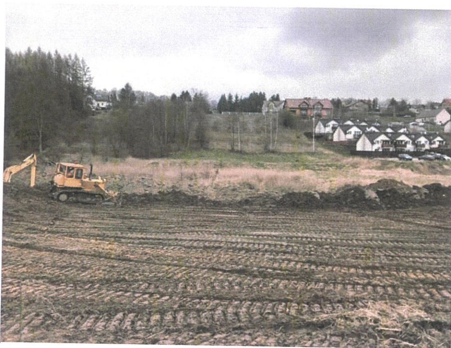
Foto. 35. Teren budowy zapory czołowej i budowli zrzutowej zbiornika, stan w trzeciej dekadzie lutego 2024 r. (widok z południowego brzegu zbiornika, w kierunku północnym).
