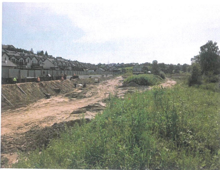
Foto. 31. Wykonywanie oczepu na ścianie szczelnej wzdłuż północnego brzegu zbiornika, stan w trzeciej dekadzie czerwca 2024 r. (widok w kierunku wschodnim).
