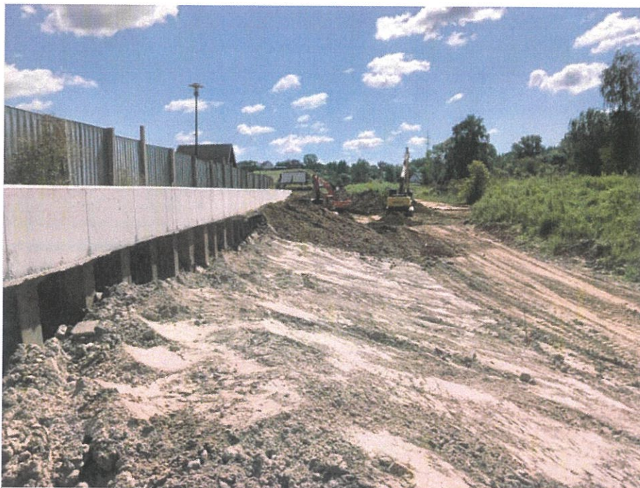
Foto. 57. Formowanie czaszy zbiornika na północnym brzegu potoku Malinówka, stan w trzeciej dekadzie lipca 2024 r. (widok w kierunku wschodnim).
