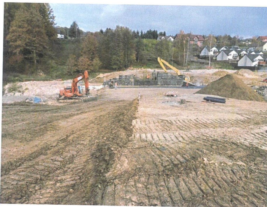
Foto. 39. Teren budowy zapory czołowej i budowli zrzutowej zbiornika, stan w trzeciej dekadzie października 2024 r. (widok z południowego brzegu zbiornika, w kierunku północnym).
