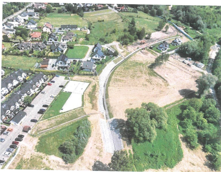
Foto. 68. Stan terenu budowy w ostatnim kwartale okresu realizacji robót – wschodnia (górną) część czaszy zbiornika, stan w drugiej dekadzie czerwca 2025 r. (widok w kierunku wschodnim).
