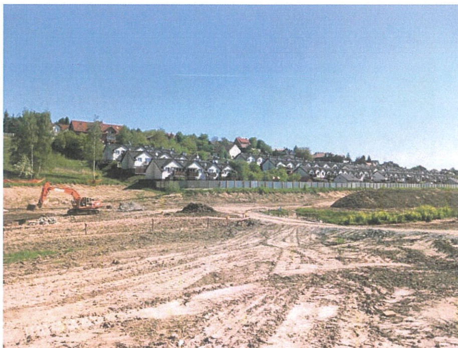
Foto. 25. Zabezpieczenie hałd humusu, stan w trzeciej dekadzie kwietnia 2024 r. (widok w kierunku wschodnim).
