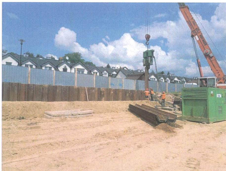
Foto. 30. Pograżanie ścianek szczelnych wzdłuż północnego brzegu zbiornika, stan w trzeciej dekadzie maja 2024 r. (widok w kierunku północnym).
