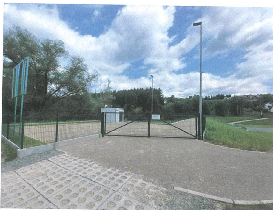
Foto. 48. Budowa placu manewrowego przy zaporze czołowej zbiornika, stan w trzeciej dekadzie czerwca 2025 r. (widok w kierunku północno-zachodnim).
