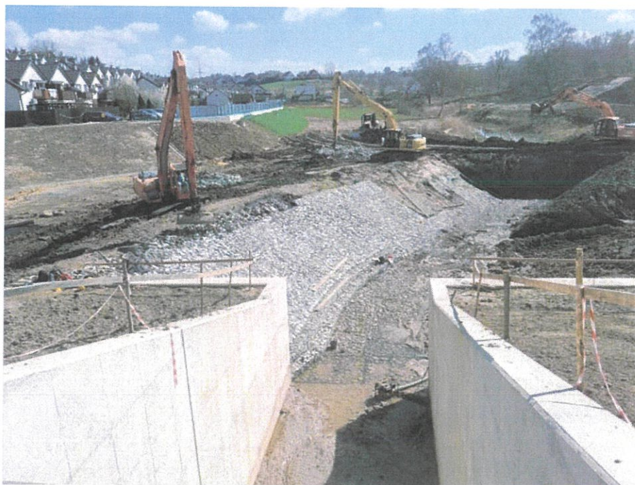
Foto. 54. Ubezpieczenie koryta potoku Malinówka powyżej budowli zrzutowej zbiornika, stan w pierwszej dekadzie kwietnia 2025 r. (widok w kierunku wschodnim).
