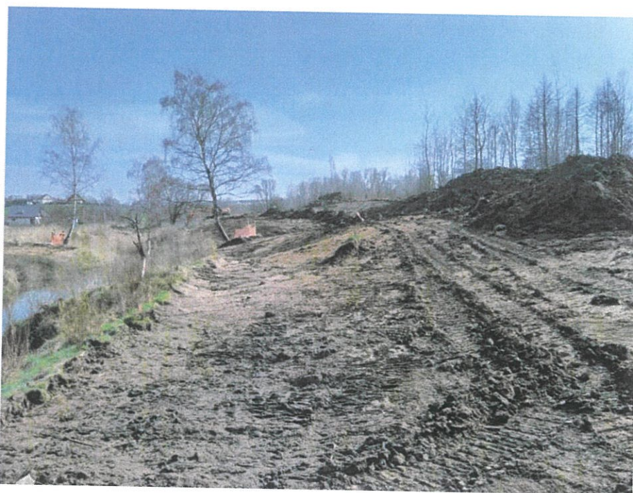
Foto. 23. Zdejmowanie warstwy humusu na południowym brzegu zbiornika, stan w drugiej dekadzie marca 2024 r. (widok w kierunku wschodnim).
