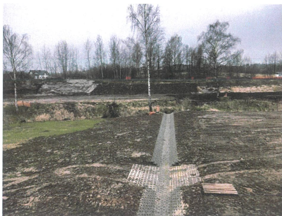
Foto. 50. Przebudowa rowu R2 w północnej części czaszy zbiornika, stan w pierwszej dekadzie kwietnia 2025 r. (widok w kierunku południowym).
