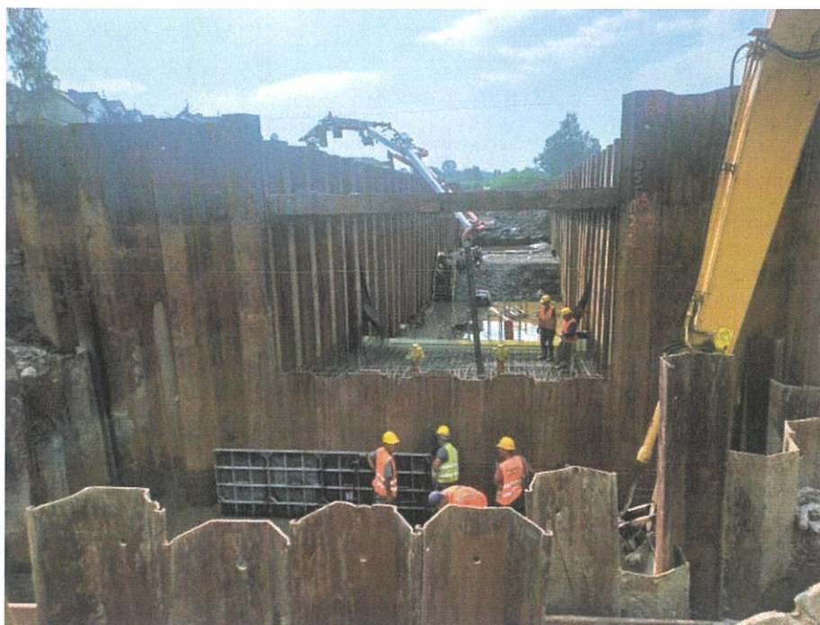
Foto. 33. Roboty żelbetowe na budowli zrzutowej zbiornika, stan w drugiej dekadzie lipca 2024 r. (widok w kierunku wschodnim).
