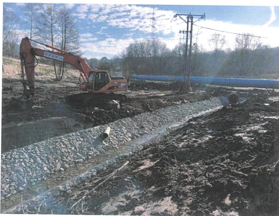
Foto. 56. Ubezpieczenie koryta potoku Malinówka w górnej części zbiornika, stan w pierwszej dekadzie lutego 2025 r. (widok w kierunku wschodnim).
