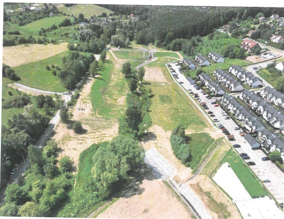
Foto. 67. Stan terenu budowy w ostatnim kwartale okresu realizacji robót – środkowa część czaszy zbiornika, stan w drugiej dekadzie czerwca 2025 r. (widok w kierunku zachodnim).
