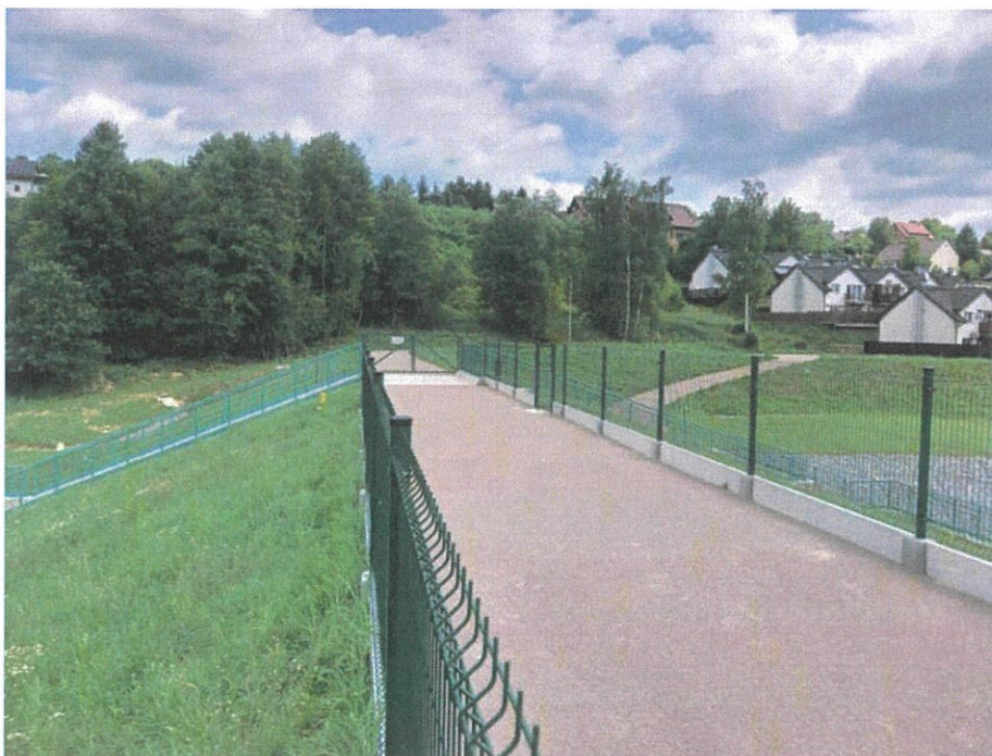
Foto. 45. Teren budowy zapory czołowej i budowli zrzutowej zbiornika, stan w trzeciej dekadzie czerwca 2025 r. (widok z południowego brzegu zbiornika, w kierunku północnym).
