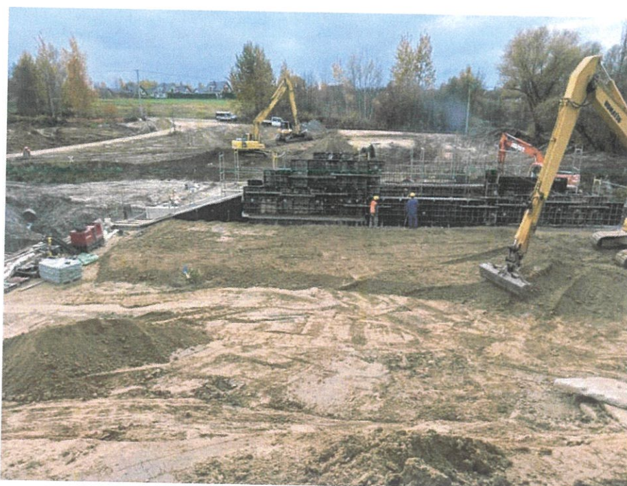
Foto. 40. Teren budowy zapory czołowej i budowli zrzutowej zbiornika, stan w trzeciej dekadzie października 2024 r. (widok z północnego brzegu zbiornika, w kierunku południowym).
