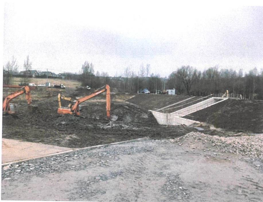
Foto. 44. Teren budowy zapory czołowej i budowli zrzutowej zbiornika, stan w pierwszej dekadzie kwietnia 2025 r. (widok z północnego brzegu zbiornika, w kierunku południowym).
