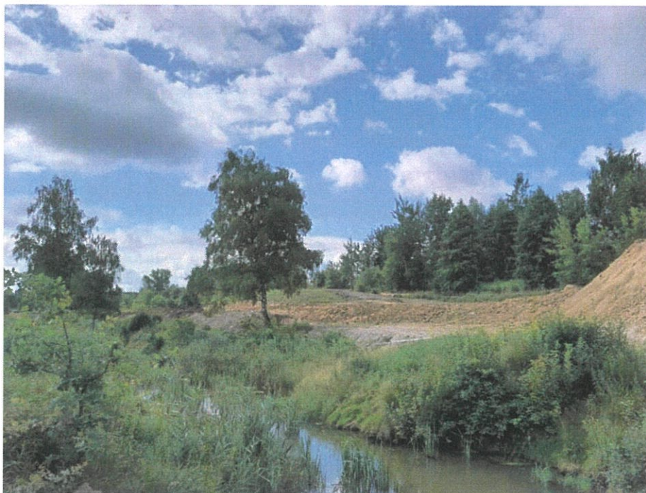
Foto. 21. Zabezpieczenie miejsc cennych przyrodniczo w granicach terenu budowy, stan w pierwszej dekadzie lipca 2024 r. (widok w kierunku wschodnim).
