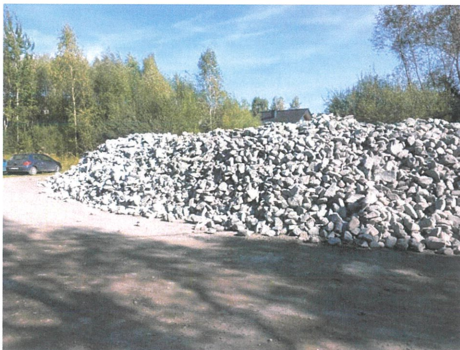
Foto. 10. Plac składowy przy ul. Koszutki, stan w trzeciej dekadzie września 2024 r. (widok w kierunku północnym).
