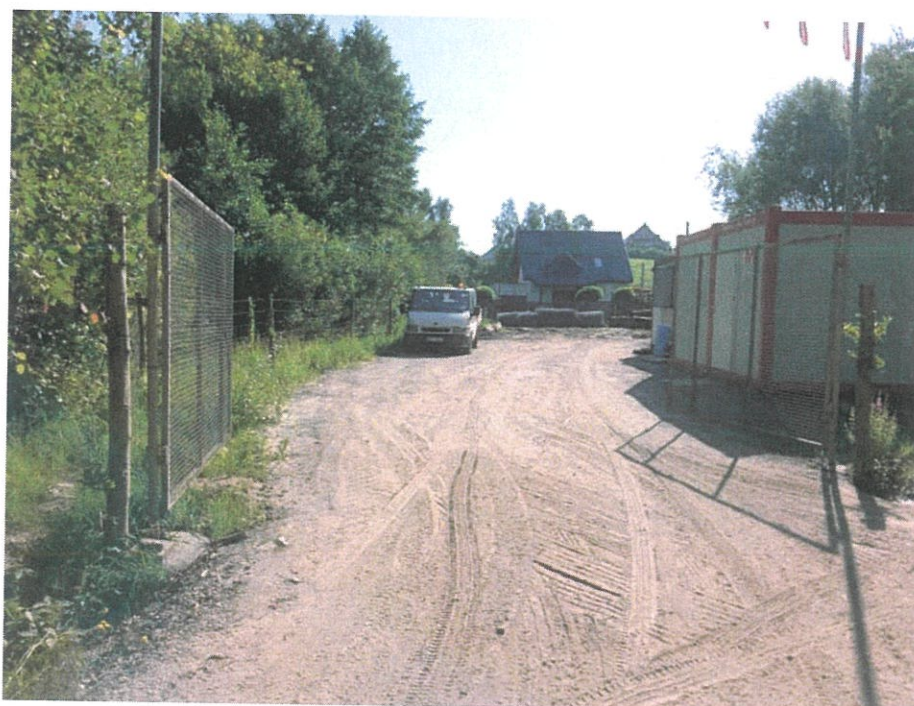
Foto. 8. Zaplecze budowy przy drodze łączącej ul. Koszutki z ul. Antoniego Hoborskiego, stan w trzeciej dekadzie kwietnia 2024 r. (widok w kierunku wschodnim).
