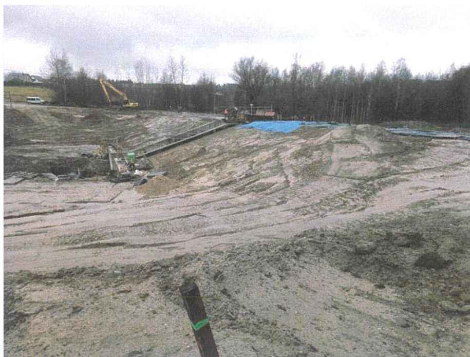
Foto. 42. Teren budowy zapory czołowej i budowli zrzutowej zbiornika, stan w trzeciej dekadzie listopada 2024 r. (widok z północnego brzegu zbiornika, w kierunku południowym).
