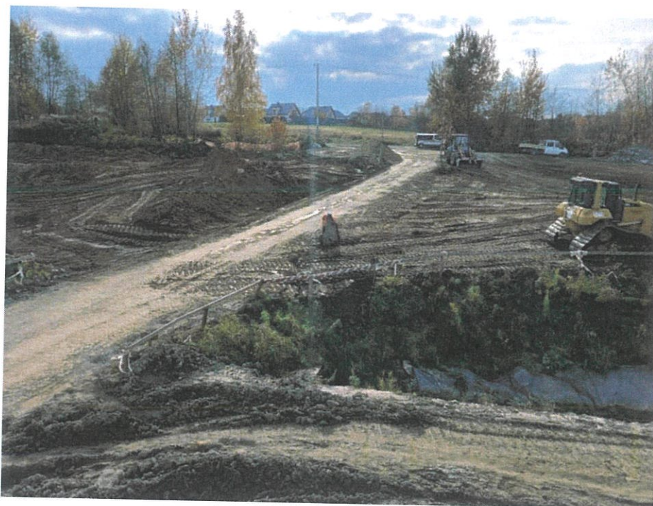
Foto. 60. Humusowanie czaszy zbiornika na południowym brzegu potoku Malinówka, stan w trzeciej dekadzie października 2024 r. (widok w kierunku południowym).
