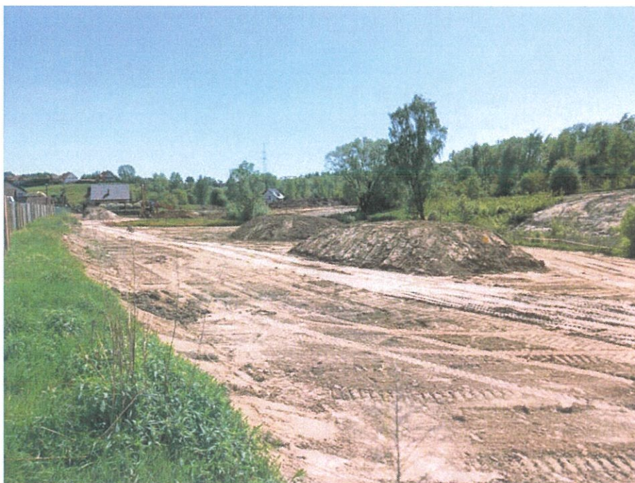
Foto. 26. Zabezpieczenie hałd humusu, stan w trzeciej dekadzie kwietnia 2024 r. (widok w kierunku wschodnim).
