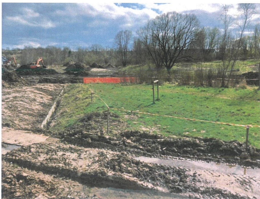
Foto. 22. Zabezpieczenie miejsc wyłączonych z prowadzenia robót, stan w trzeciej dekadzie marca 2024 r. (widok w kierunku południowym).
