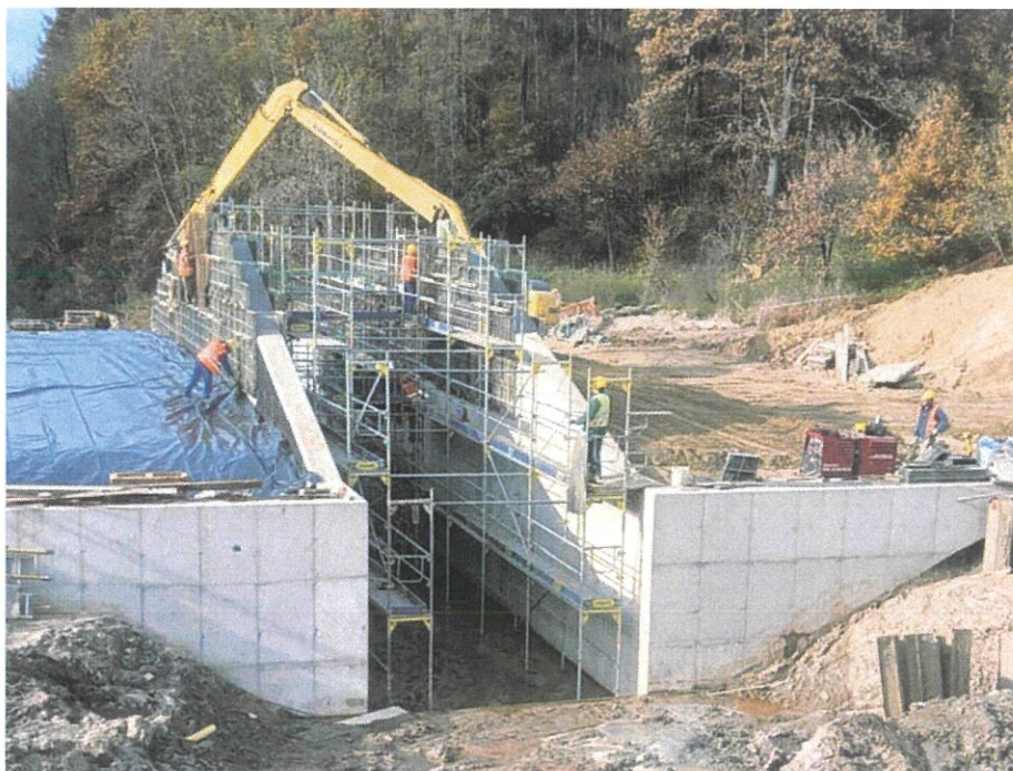
Foto. 34. Roboty żelbetowe na budowli zrzutowej zbiornika, stan w trzeciej dekadzie października 2024 r. (widok w kierunku zachodnim).
