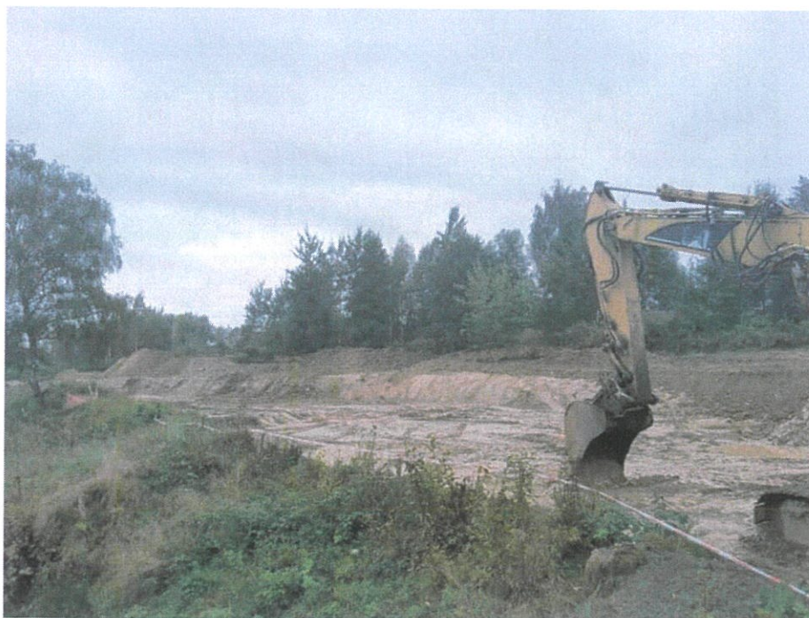
Foto. 58. Formowanie czaszy zbiornika na południowym brzegu potoku Malinówka, stan w pierwszej dekadzie października 2024 r. (widok w kierunku wschodnim).
