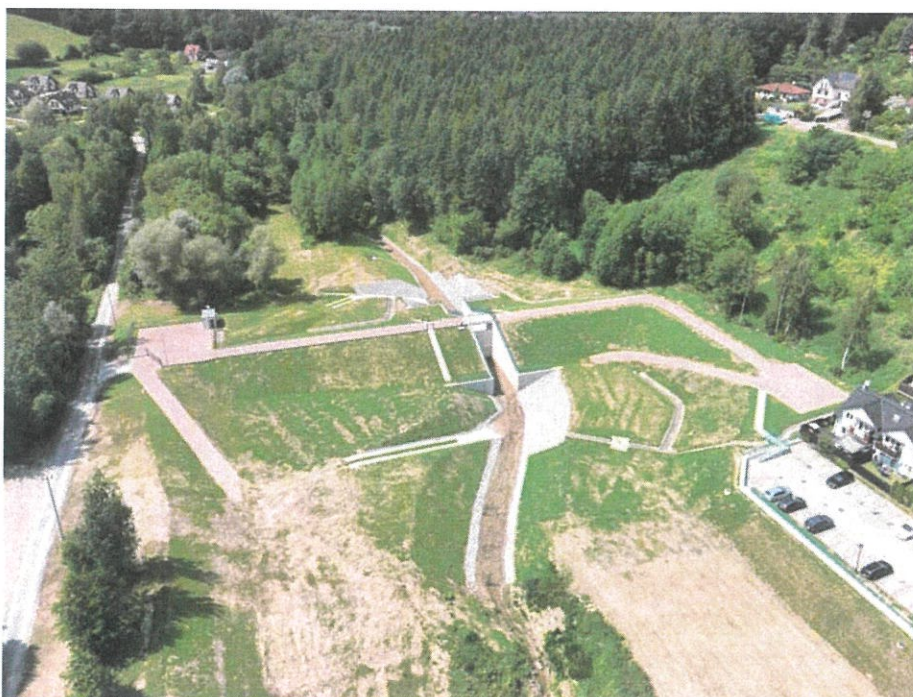
Foto. 65. Stan terenu budowy w ostatnim kwartale okresu realizacji robót – zachodnia (dolna) część czaszy zbiornika, stan w drugiej dekadzie czerwca 2025 r. (widok w kierunku zachodnim).
