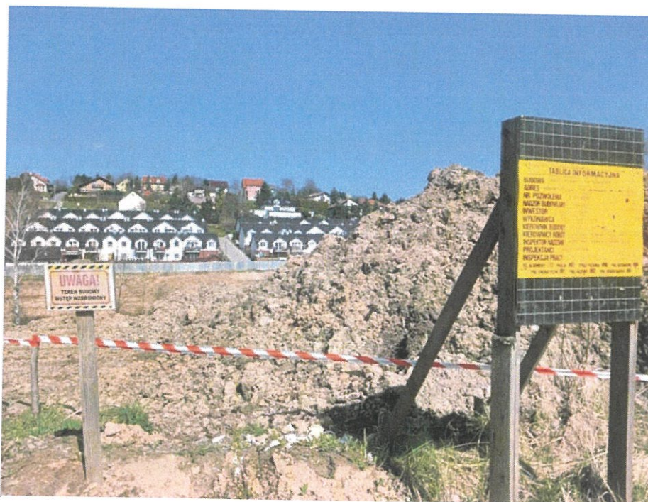
Foto. 15. Oznakowanie terenu budowy, stan w trzeciej dekadzie marca 2024 r. (widok w kierunku północnym).
