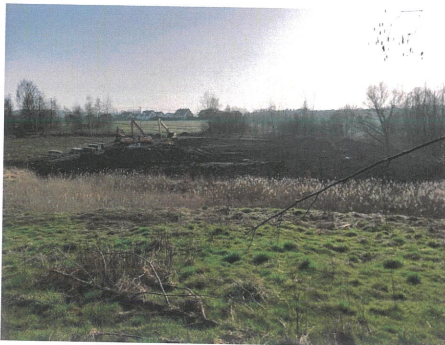
Foto. 36. Teren budowy zapory czołowej i budowli zrzutowej zbiornika, stan w trzeciej dekadzie lutego 2024 r. (widok z północnego brzegu zbiornika, w kierunku południowym).
