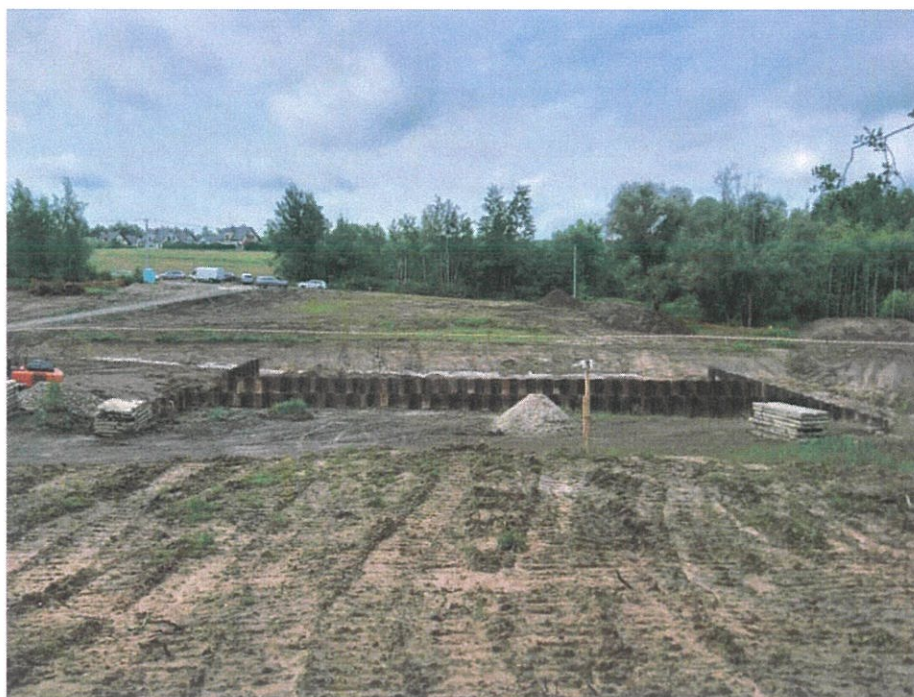
Foto. 38. Teren budowy zapory czołowej i budowli zrzutowej zbiornika, stan w trzeciej dekadzie maja 2024 r. (widok z północnego brzegu zbiornika, w kierunku południowym).
