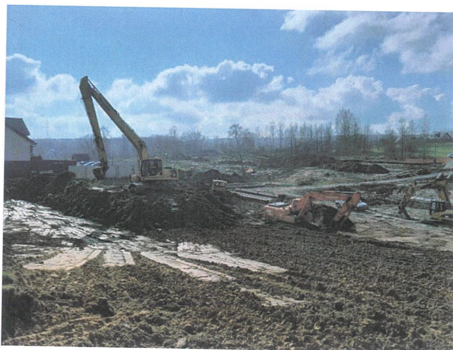
Foto. 24. Zdejmowanie warstwy humusu na północnym brzegu zbiornika, stan w drugiej dekadzie marca 2024 r. (widok w kierunku wschodnim).
