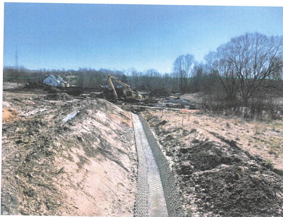
Foto. 52. Przebudowa rowu R4 w północnej części czaszy zbiornika, stan w trzeciej dekadzie marca 2025 r. (widok w kierunku południowo-wschodnim).
