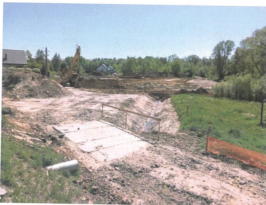
Foto. 51. Przebudowa rowu R4 w północnej części czaszy zbiornika, stan w trzeciej dekadzie kwietnia 2024 r. (widok w kierunku południowo-wschodnim).
