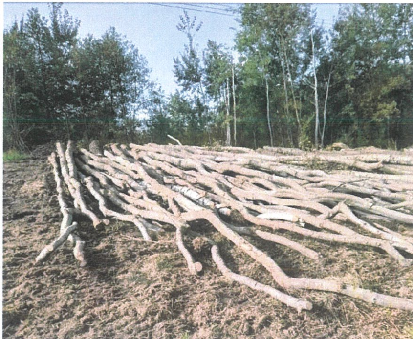
Foto. 6. Porządkowanie terenu po wycince drzew (I etap realizacji Kontraktu), stan w trzeciej dekadzie września 2022 r. (widok w kierunku południowym).
