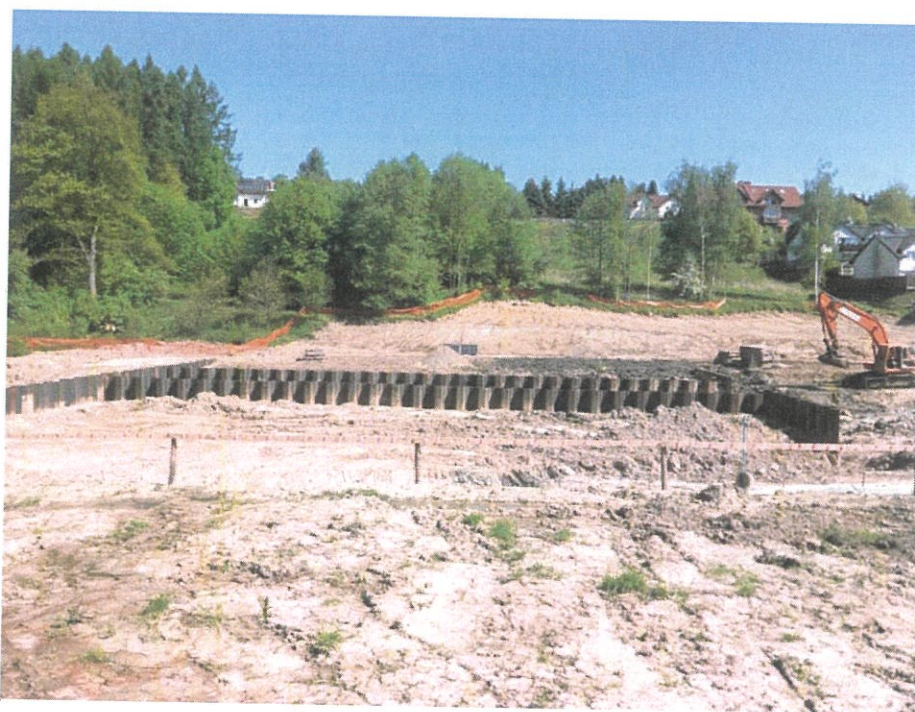
Foto. 19. Zabezpieczenie drzew nie planowanych do wycinki, stan w trzeciej dekadzie kwietnia 2024 r. (widok w kierunku północnym).
