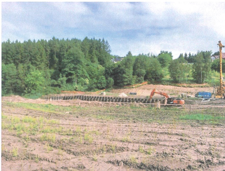
Foto. 37. Teren budowy zapory czołowej i budowli zrzutowej zbiornika, stan w trzeciej dekadzie maja 2024 r. (widok z południowego brzegu zbiornika, w kierunku północnym).
