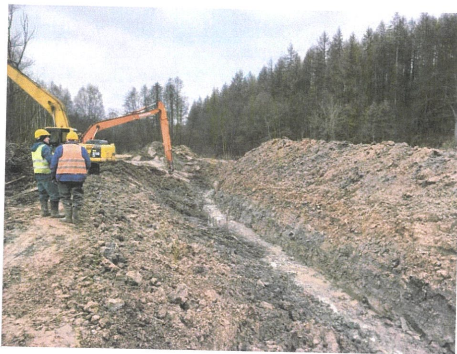
Foto. 27. Budowa kanału obiegowego potoku Malinówka na czas budowy zapory zbiornika, stan w trzeciej dekadzie lutego 2024 r. (widok w kierunku zachodnim).
