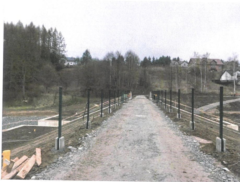
Foto. 43. Teren budowy zapory czołowej i budowli zrzutowej zbiornika, stan w pierwszej dekadzie kwietnia 2025 r. (widok z południowego brzegu zbiornika, w kierunku północnym).
