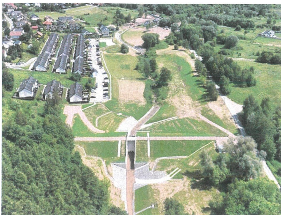
Foto. 66. Stan terenu budowy w ostatnim kwartale okresu realizacji robót – zachodnia (dolna) część czaszy zbiornika, stan w drugiej dekadzie czerwca 2025 r. (widok w kierunku wschodnim).
