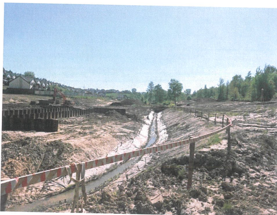
Foto. 28. Kanał obiegowy potoku Malinówka na czas budowy zapory zbiornika, stan w trzeciej dekadzie kwietnia 2024 r. (widok w kierunku zachodnim).
