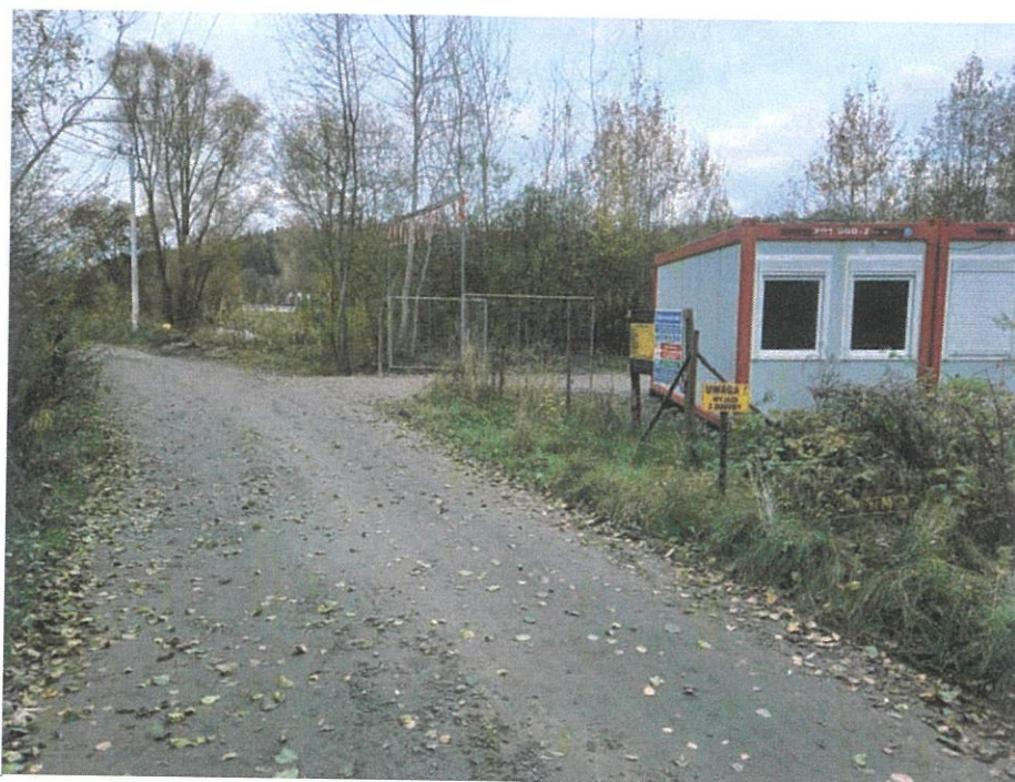
Foto. 11. Droga dojazdowa do zaplecza budowy, stan w trzeciej dekadzie października 2024 r. (widok w kierunku zachodnim).
