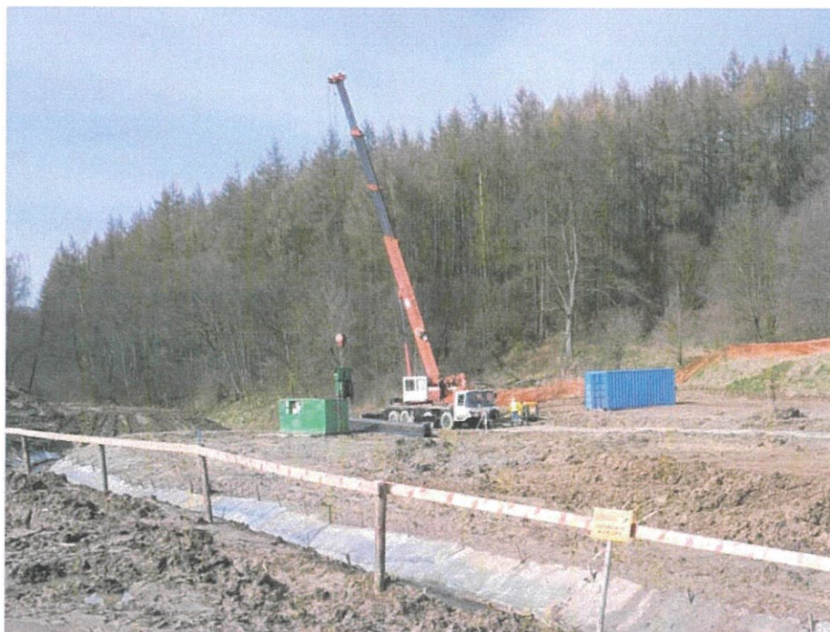
Foto. 29. Pograżanie ścianek szczelnych na budowie zapory czołowej zbiornika, stan w drugiej dekadzie marca 2024 r. (widok w kierunku zachodnim).
