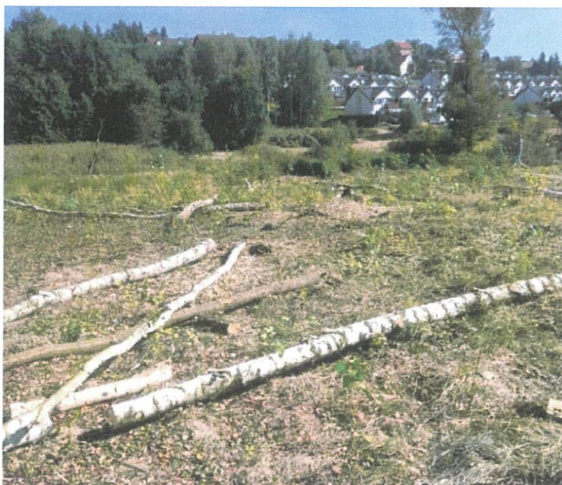
Foto. 5. Wycinka drzew (I etap realizacji Kontraktu), stan w pierwszej dekadzie września 2022 r. (widok w kierunku północnym).
