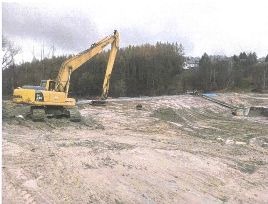
Foto. 41. Teren budowy zapory czołowej i budowli zrzutowej zbiornika, stan w trzeciej dekadzie listopada 2024 r. (widok z południowego brzegu zbiornika, w kierunku północnym).
