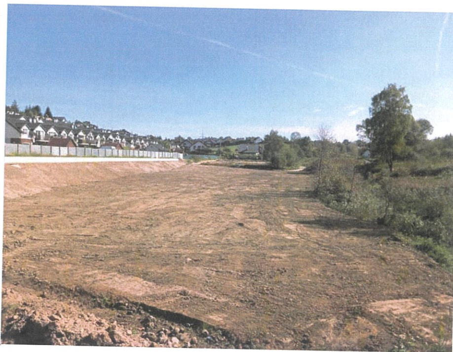
Foto. 59. Humusowanie czaszy zbiornika na północnym brzegu potoku Malinówka, stan w trzeciej dekadzie września 2024 r. (widok w kierunku wschodnim).
