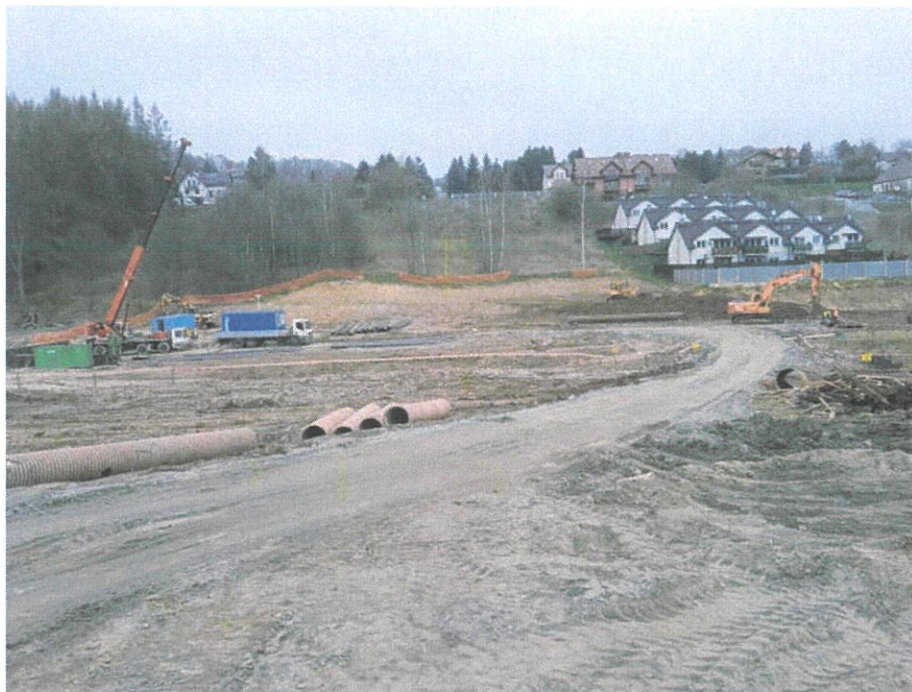
Foto. 14. Droga technologiczna do miejsca budowy zapory czołowej zbiornika, stan w trzeciej dekadzie marca 2024 r. (widok w kierunku północnym).
