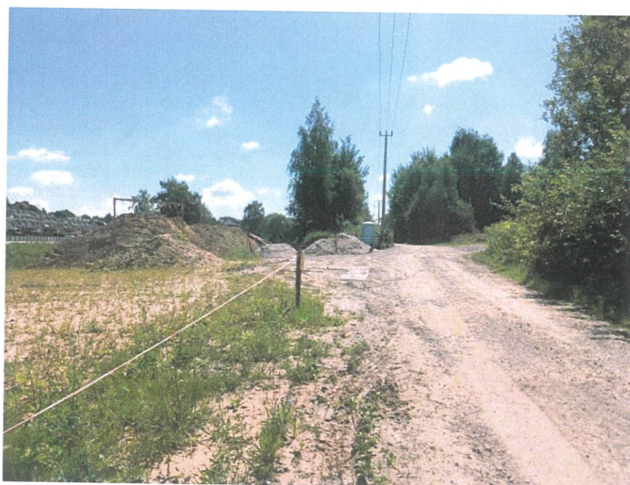
Foto. 12. Droga dojazdowa do terenu budowy, stan w trzeciej dekadzie lipca 2024 r. (widok w kierunku wschodnim).
