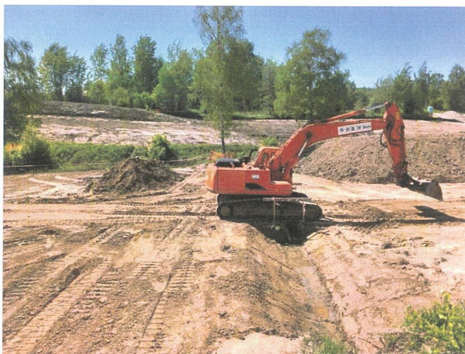
Foto. 49. Przebudowa rowu R2 w północnej części czaszy zbiornika, stan w trzeciej dekadzie kwietnia 2024 r. (widok w kierunku południowym).
