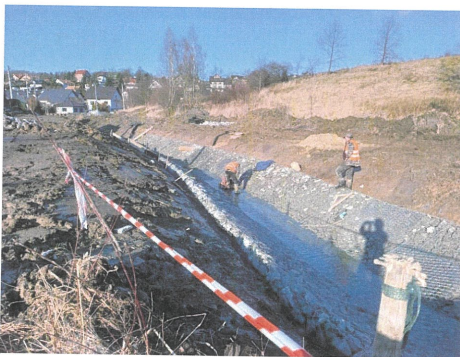
Foto. 55. Ubezpieczenie koryta potoku Malinówka w górnej części zbiornika, stan w trzeciej dekadzie stycznia 2025 r. (widok w kierunku zachodnim).
