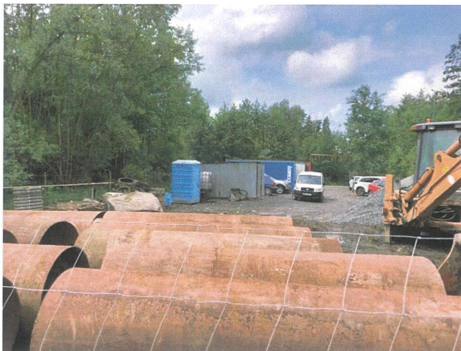
Foto. 9. Zaplecze budowy przy drodze łączącej ul. Koszutki z ul. Antoniego Hoborskiego, stan w trzeciej dekadzie czerwca 2024 r. (widok w kierunku północnym).
