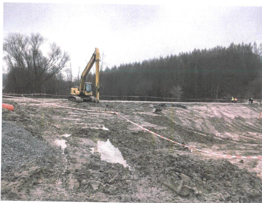
Foto. 16. Oznakowanie terenu budowy, stan w trzeciej dekadzie grudnia 2024 r. (widok w kierunku zachodnim).
