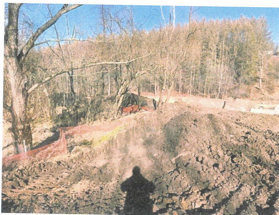
Foto. 20. Zabezpieczenie drzew nie planowanych do wycinki, stan w pierwszej dekadzie lutego 2025 r. (widok w kierunku północnym).
