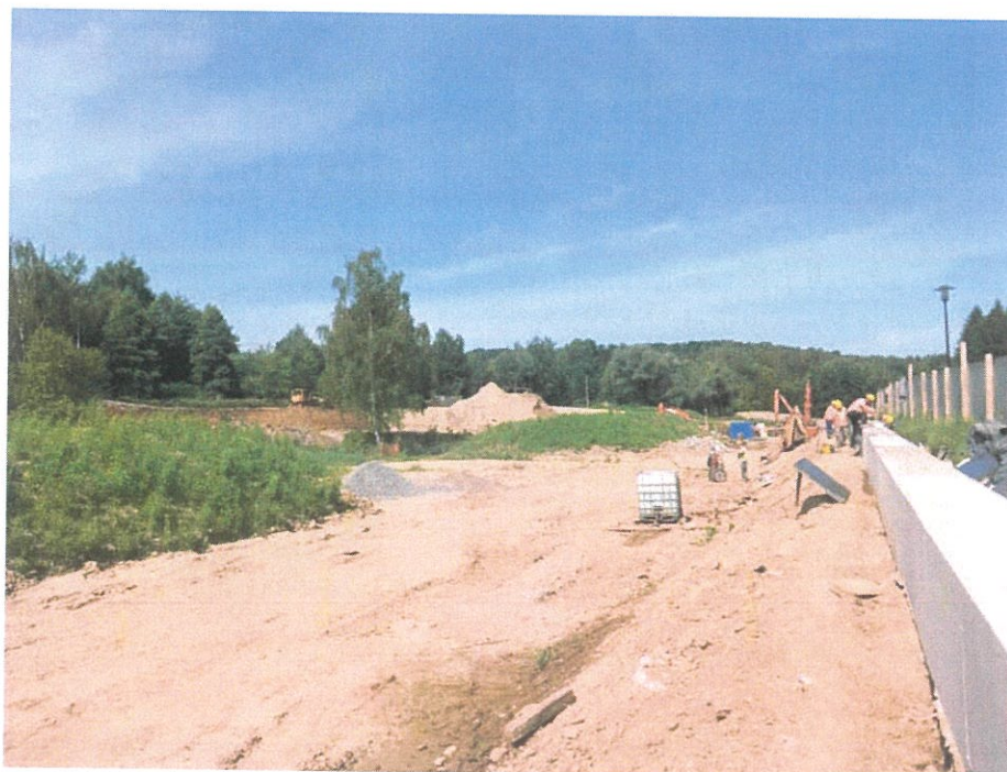
Foto. 32. Wykonywanie oczepu na ścianie szczelnej wzdłuż północnego brzegu zbiornika, stan w trzeciej dekadzie czerwca 2024 r. (widok w kierunku zachodnim).
