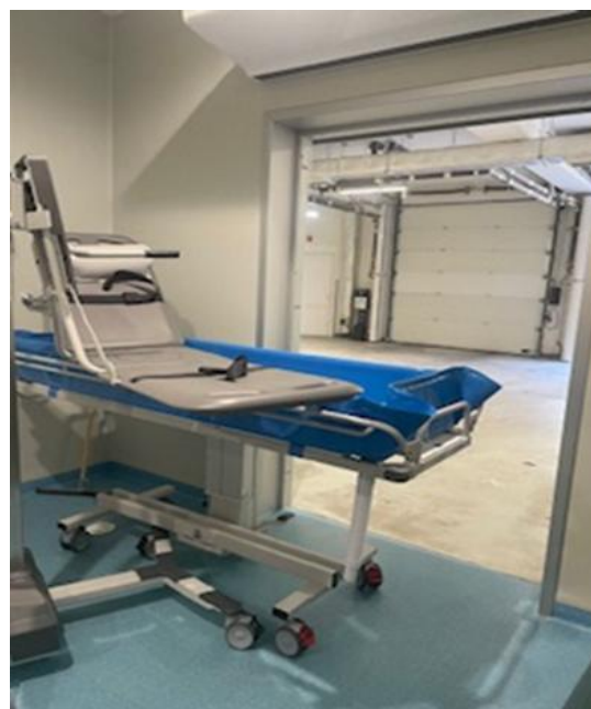
SOR sala dekontaminacji - wózkowanna Fot. Renata Bednarska
