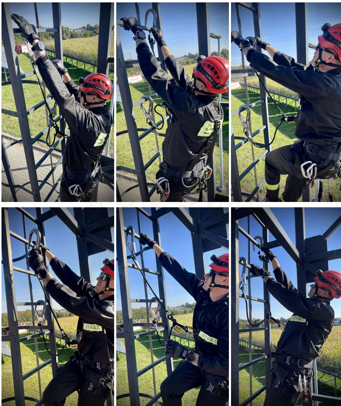
Fot. 76 Poruszanie się z lonżą typu Y z absorberem energii.
