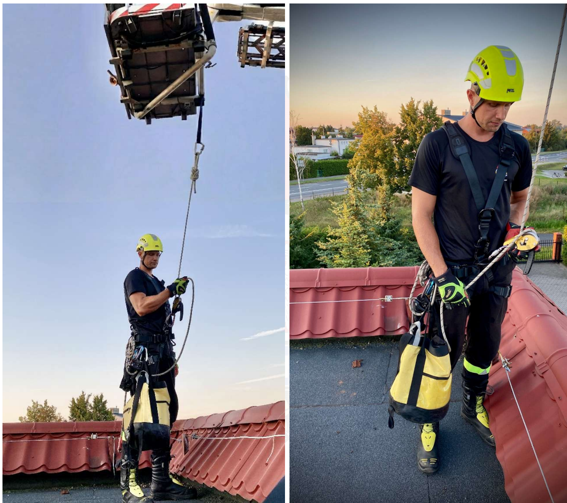
Fot. 75 Asekuracja na dachu z wykorzystaniem wysięgnika.
