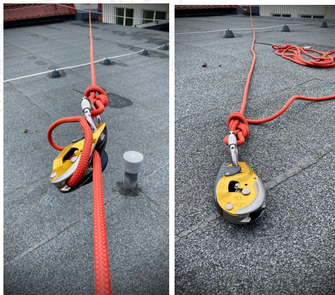
Fot. 59 Przykłady budowania stanowisk z liny.
