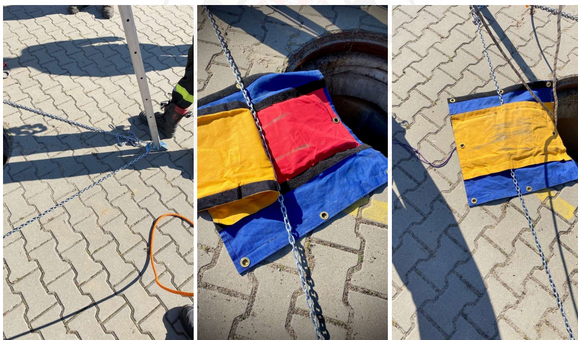
Fot. 152 Ustawienie zestawu do ewakuacji ze studni.
