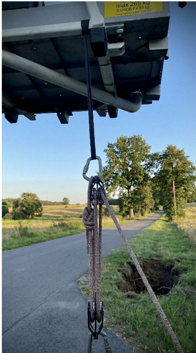
Fot. 161 Układ 4:1 z wykorzystaniem ramienia wysięgnika jako stanowisko.
