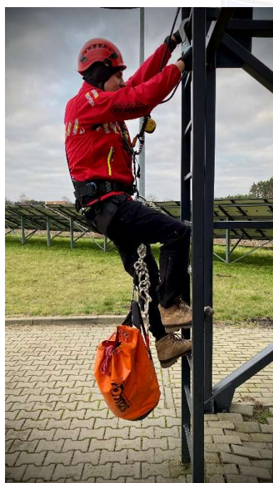
Fot. 50 Przykład przenoszenia sprzętu podczas wchodzenia po drabinie.
