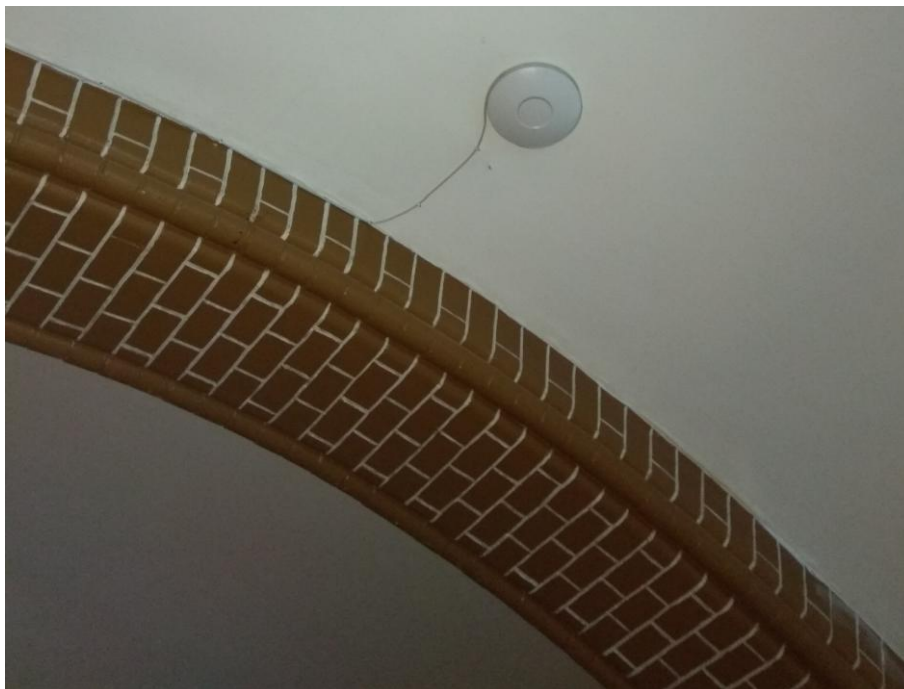
Fot. 1: Widok punktu dostępowego model UniFi – UAP
